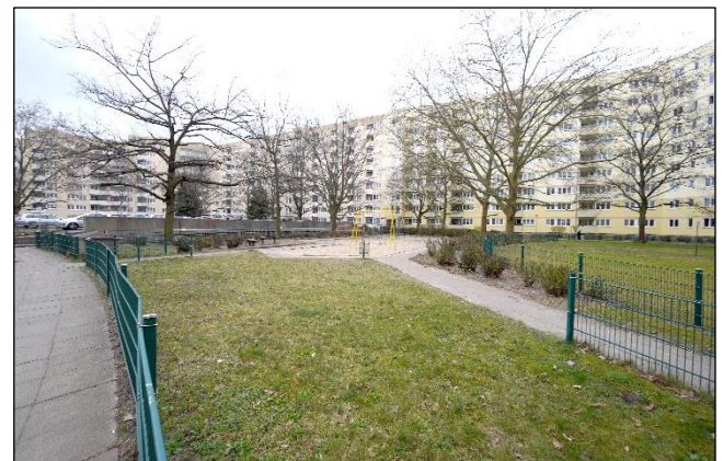
Freiflächen der Gesamtanlage
