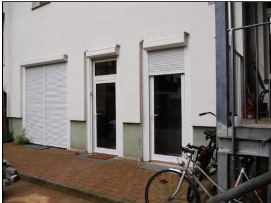
Erdgeschosszone des linken Seitenflügels
