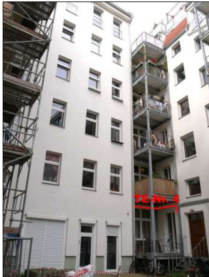
Blick aus dem Bereich der Gebäudedurchfahrt des Vorderhauses auf die hofseitigen Fronten des linken Seitenflügels und des rechts im Bild anbindenden Quergebäudes mit TE-Nr. 4
