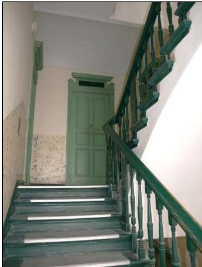
Treppenhaus- aufgang im Vor- derhaus mit 3- spänniger Voll- geschosspo- destfläche
