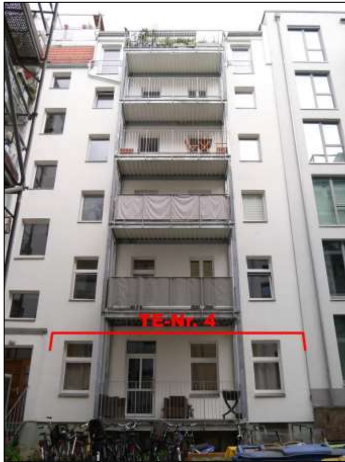
Blick aus der Gebäudedurchfahrt im Vorderhaus auf die hofseitige Front des Quergebäudes mit TE-Nr. 4 im Erdgeschoss
