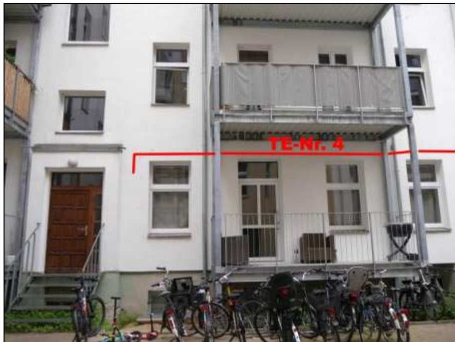
hofseitige Front des Quergebäudes im Bereich des Hochparterres und des Souterrains mit Differenztreppe zum Hochparterre mit TE-Nr. 4 mit anbindendem Quergebäudetreppenhaus
