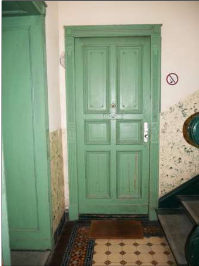
Treppenhaus- aufgang im Erdgeschoss des Vorderhau- ses mit links und im Hinter- grund anbin- denden Zu- gangstüren des Wohnungsei- gentums Nr. 2
