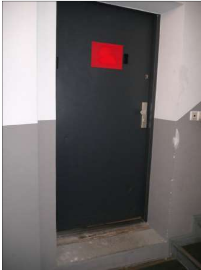
Eingangstür des Teileigentums Nr. 4 im Haus- eingangsbereich des Quergebäu- des
