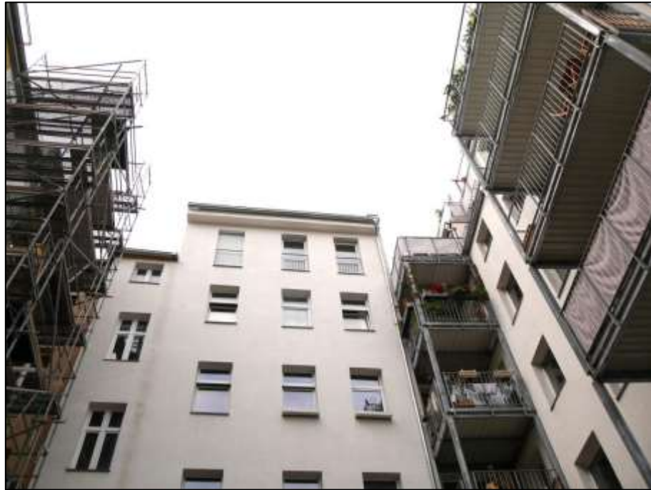
Blick aus dem Hof des Anwesens auf die Obergeschosse des linken Seitenflügels mit geschosshoch aufgestocktem Dachgeschoss und entsprechend aufgestocktem Quergebäude nebst Aufdachterrasse sowie links im Bild anbindendes Vorderhaus mit derzeit durchgeführten Bauarbeiten im Dachbereich nebst Einrüstung der Hoffassade
