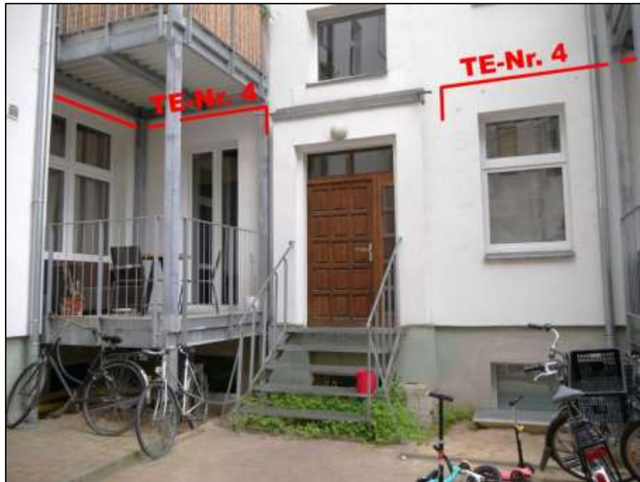
hofseitigen Fronten des linken Seitenflügels links im Bild und des hieran rechts anbindenden Quergebäudes im Bereich des Hochparterres und des darunter belegenen Souterrains sowie Differenzterasse zum Hochparterre mit anbindendem Quergebäudetreppenhaus und TE-Nr. 4
