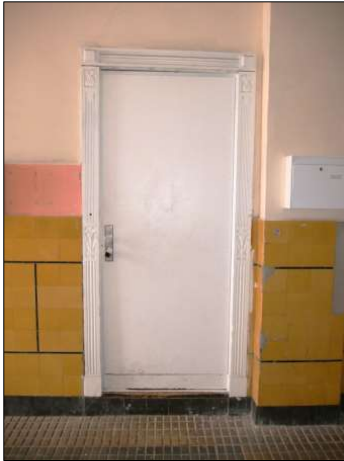
in der Gebäudedurchfahrt des Vorderhauses im Erdgeschoss postalisch rechts anbindendes Teileigentum Nr. 1
