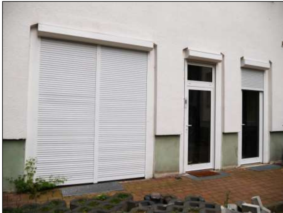
Erdgeschosszone des linken Seitenflügels mit TE-Nr. 3
