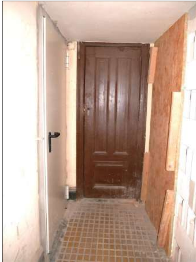
Blick aus der Gebäudedurchfahrt im Vorderhaus in den hieraus abgehenden Stichflur zu einem vorgesehenen Zugang eines sogenannten Fassadenaufzugs und dem Kellertreppenabgang im Hintergrund sowie links im Bestand anbindender Abstellkammer
