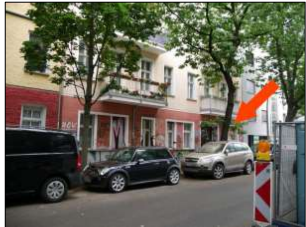
Gebäudedurchfahrt a.d. Grdst. Kreutzigerstr. 5
