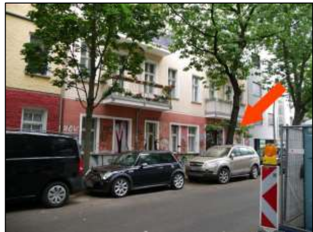
Gebäudedurchfahrt a.d. Grdst. Kreutzigerstr. 5
