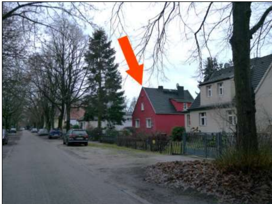
Blick aus der Bilsenkrautstraße nach Süd-Westen mit Lage des auf dem Grundstück Bilsenkrautstr. 15 aufstehenden Einfamilienhauses (Pfeil)
