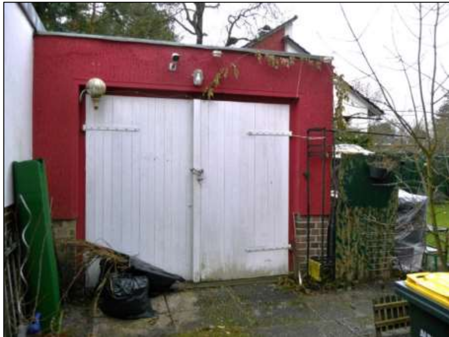
separate Grenzgarage auf dem Grundstück Bilsenkrautstraße 15
