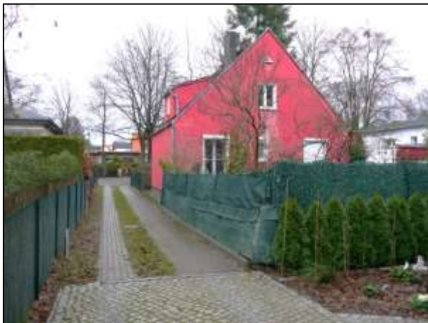
gartenseitige Gebäudefront und GFL-Recht
