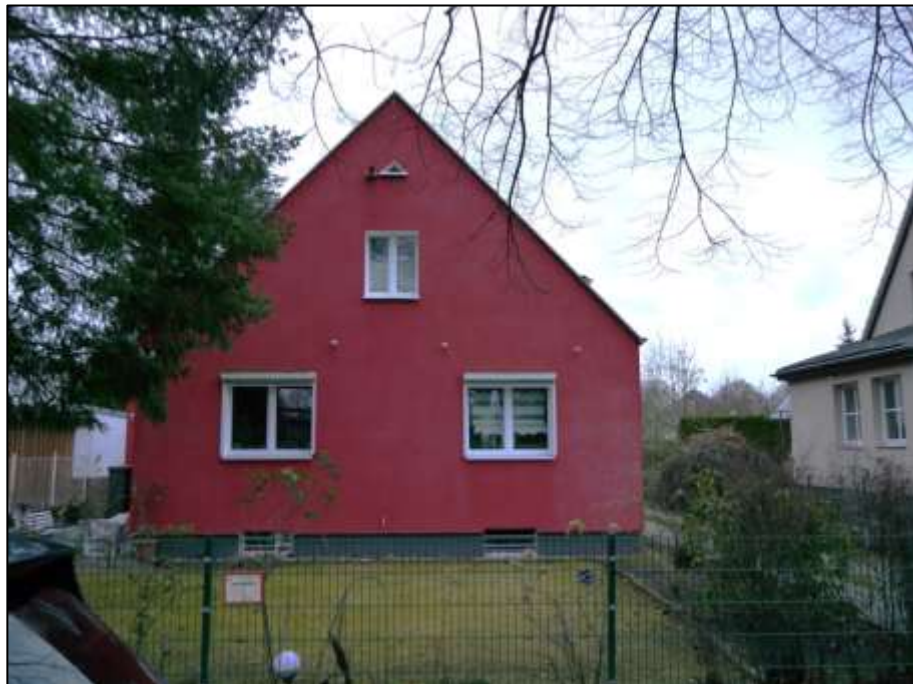
Blick aus dem Straßenraum der Bilsenkrautstraße vor dem Grundstück nach Westen auf das auf dem Grundstück Bilsenkrautstr. 15 aufstehende Einfamilienhaus mit östlicher Giebelseite
