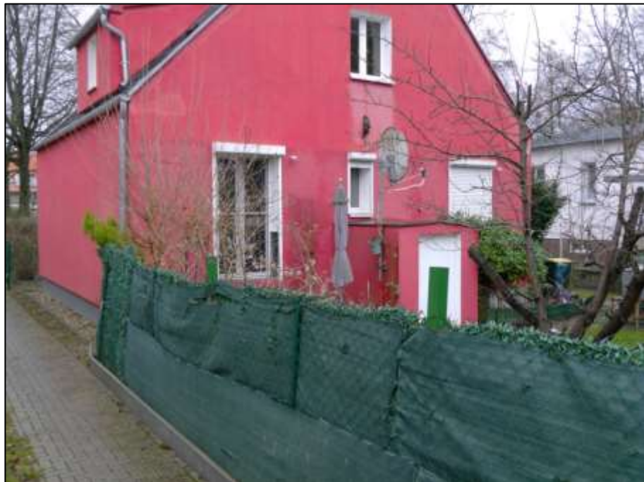
Blick aus dem Erschließungskorridor zugunsten des herrschenden Hinterliegergrundstücks mit dorthin separat umfriedetem Gartenteil des dienenden Grundstücks auf die westliche Giebelseite des auf dem dienenden Grundstück aufstehenden Einfamilienhauses
