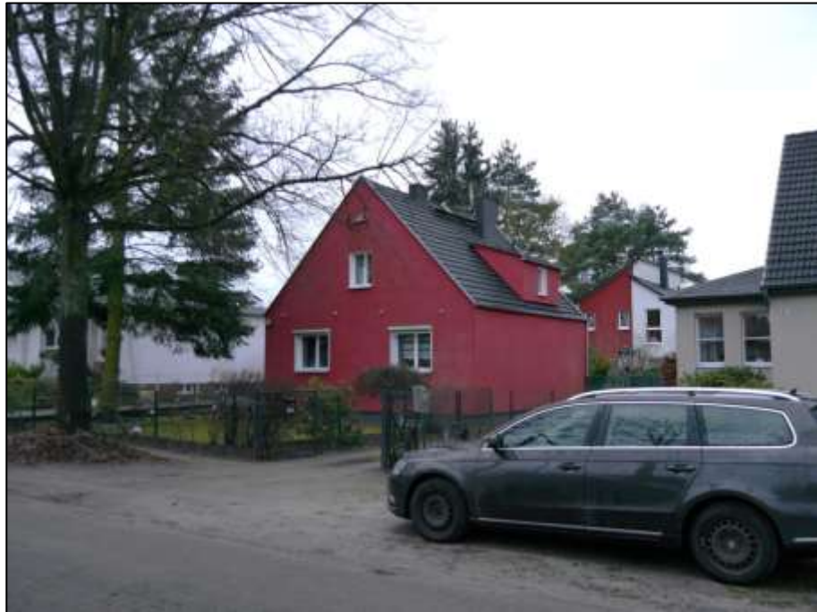
Blick aus dem Straßenraum der Bilsenkrautstraße vor dem Grundstück nach Süd-Westen auf das auf dem Grundstück Bilsenkrautstr. 15 aufstehende Einfamilienhaus
