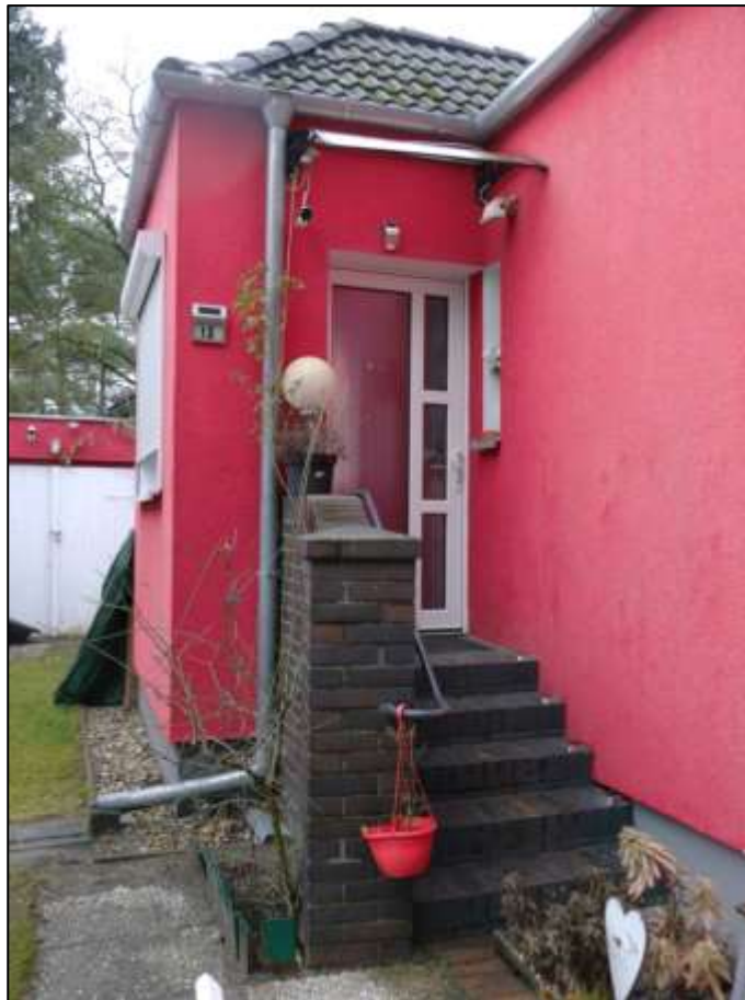
in den linken Bauwich auskoffernder Windfangvorbau mit Differenzstufe zum Hauseingang
