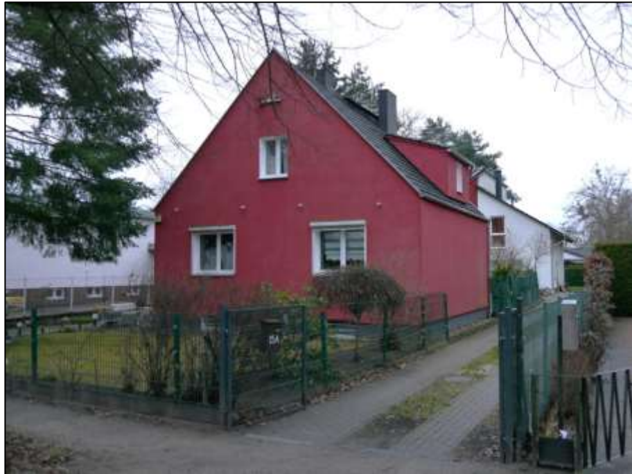
Blick aus dem Straßenraum der Bilsenkrautstraße vor dem Grundstück nach Westen auf das auf dem Grundstück Bilsenkrautstr. 15 aufstehende Einfamilienhaus mit zum rechten Bauwich orientierter Gebäudefront und Zufahrt auf das GFL-Recht zu dem auf dem Hinterliegergrundstück belegenen Einfamilienhaus im Vordergrund
