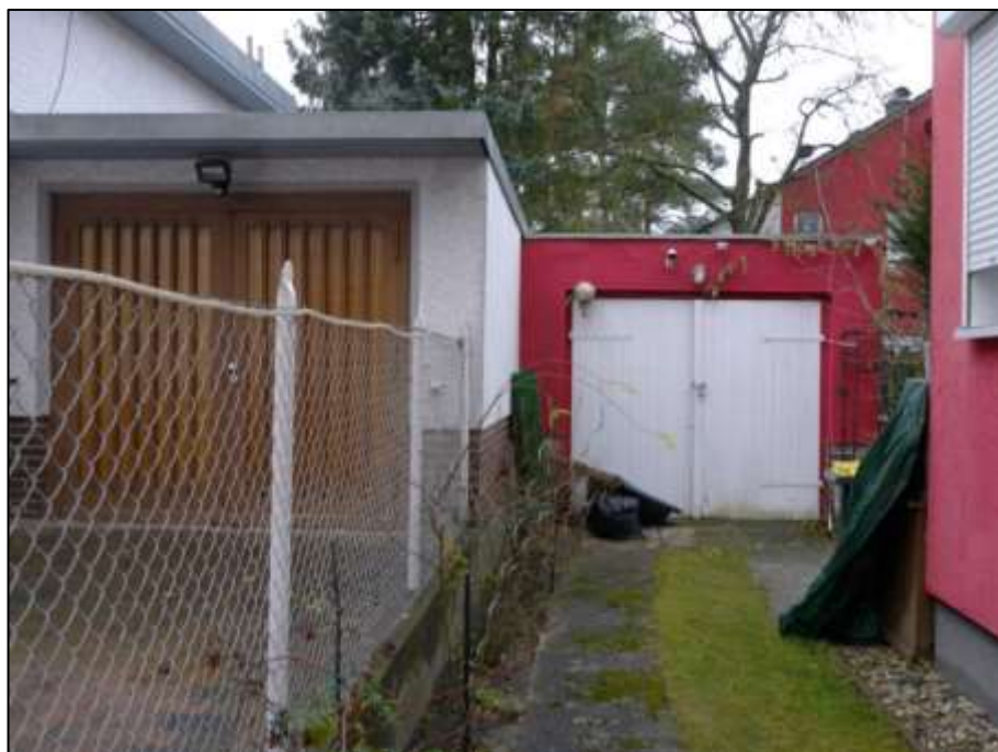
über den linken Bauwich anzufahrende separate Grenzgarage auf dem Grundstück Bilsenkrautstr. 15 und Windfangvorbau rechts im Bild
