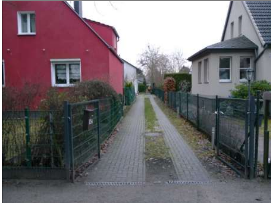
straßenseitige Front des Grundstücks Bilsenkrautstr. 15 im Bereich der Zufahrt in den rechten Bauwich des Grundstücks mit Belastung durch ein GFL-Recht zugunsten des herrschenden Hinterliegergrundstücks
