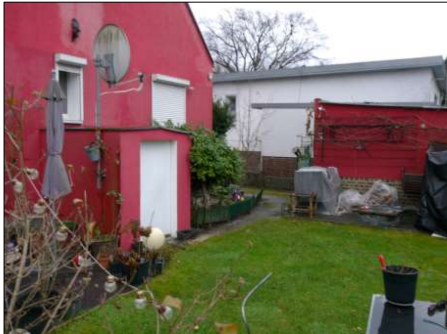
Blick aus dem Erschließungskorridor über die separate Umfriedung des Gartenteils des dienenden Grundstücks hinweg auf die westliche Giebelseite des aufstehenden Einfamilienhauses mit separatem Vorbau als Einhausung der Kellertreppe und separate Grenzgarage (rechts im Bild)
