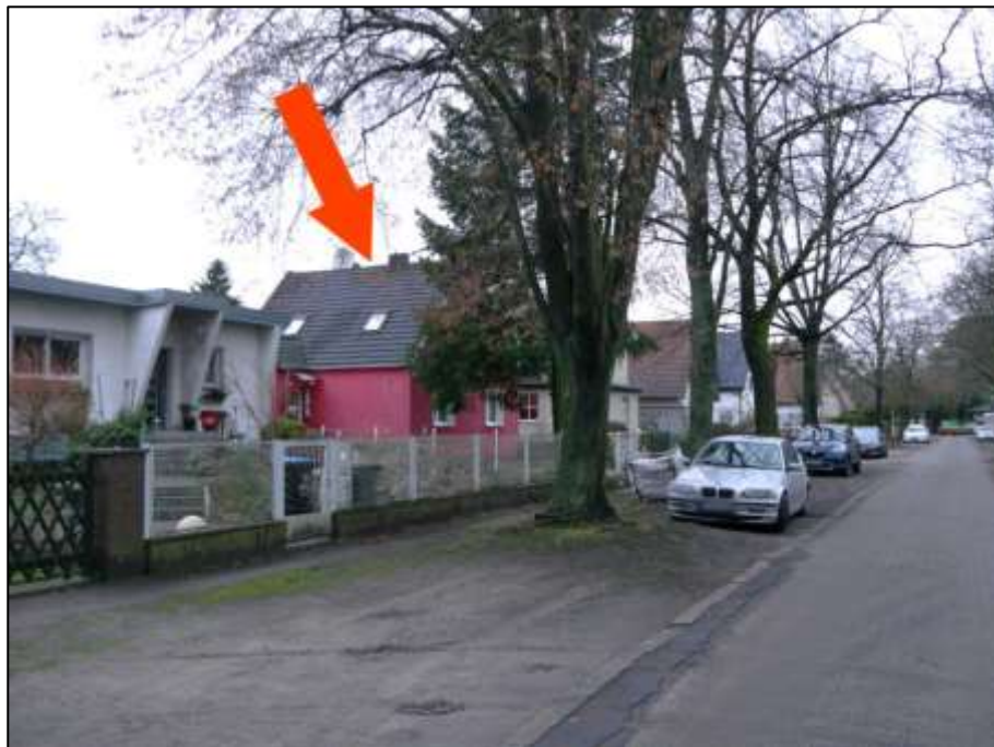
Blick aus der Bilsenkrautstraße nach Nord-Westen mit Lage des auf dem Grundstück Bilsenkrautstr. 15 aufstehenden Einfamilienhauses (Pfeil)
