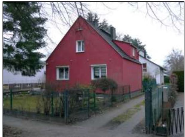
straßenseitige Giebelseite des Wohnhauses
