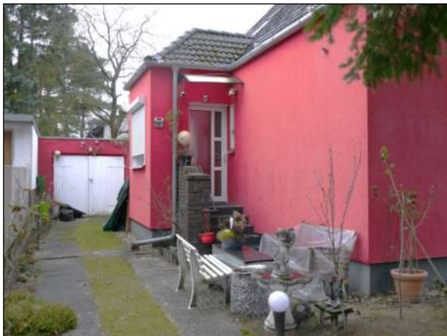
Garagenzufahrt im linken Bauwich des Grundstücks mit in den Bau-wich auskofferndem Windfangvorbau sowie dahinter belegene separa-te Grenzgarage im Hintergrund
