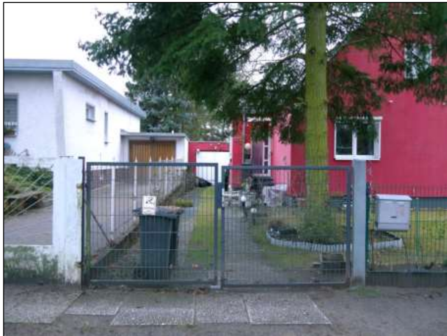
straßenseitige Front des Grundstücks Bilsenkrautstr. 15 im Bereich der Zufahrt in den linken Bauwich des Grundstücks mit einfacher Doppel-flügel-Toranlage u.a. als Schlupfporte zur Hauszuwegung mit in den Bauwich auskofferndem Windfangvorbau sowie dahinter belegener separater Grenzgarage im Hintergrund
