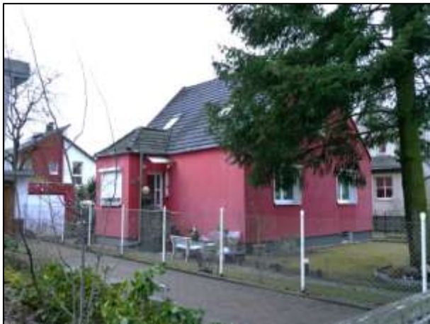
Grdst. Bilsenkrautstr. 15 mit Einfamilienhaus
