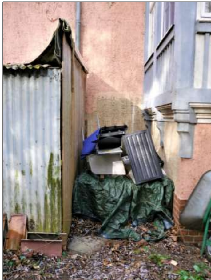
Fehlstellen des Fassadenanstrichs im Sockelbereich des Veranda-Vorbaus und verbliebener Sperrmüll hinter dem Wellblechschuppen
