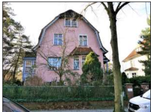
straßenseitiger Giebel des Wohngebäudes
