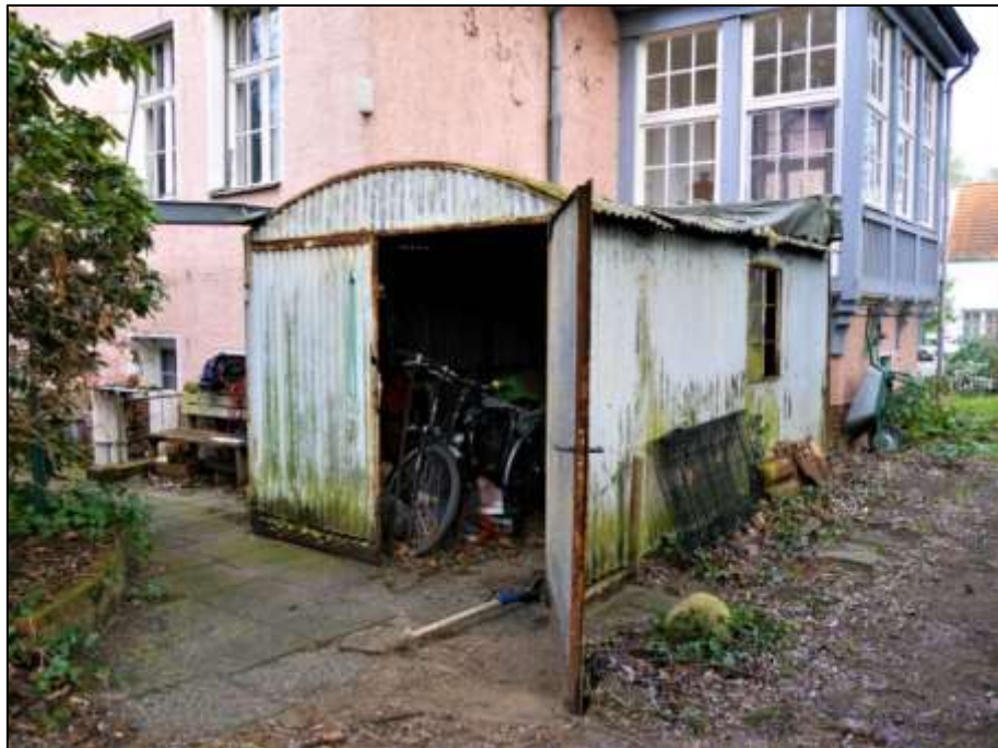
völlig verbrauchter und abzufahrender Wellblechschuppen im linken Bauwich des Wohngebäudes und links im Bild sichtbare Kelleraußentür mit davor belegener Zugangstreppe
