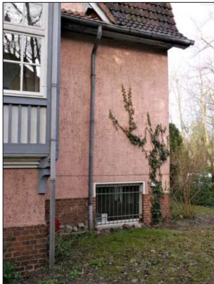
zum linken Bauwich orien- tierte Gebäude- front mit nach- träglich einge- bautem Fenster im Souterrain
