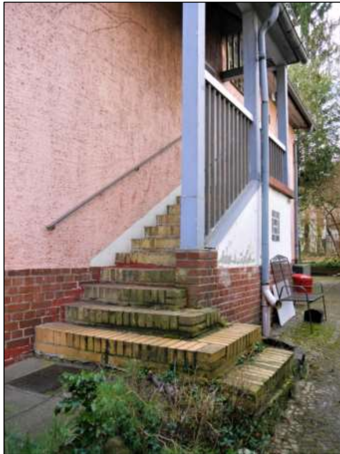
gedeckte Haus- eingangstreppe zum Hochpar- terre mit extrem hohen Antritts- stufen als Un- fallgefahrenstel- le insbesondere beim Herunter- gehen auf der Treppe
