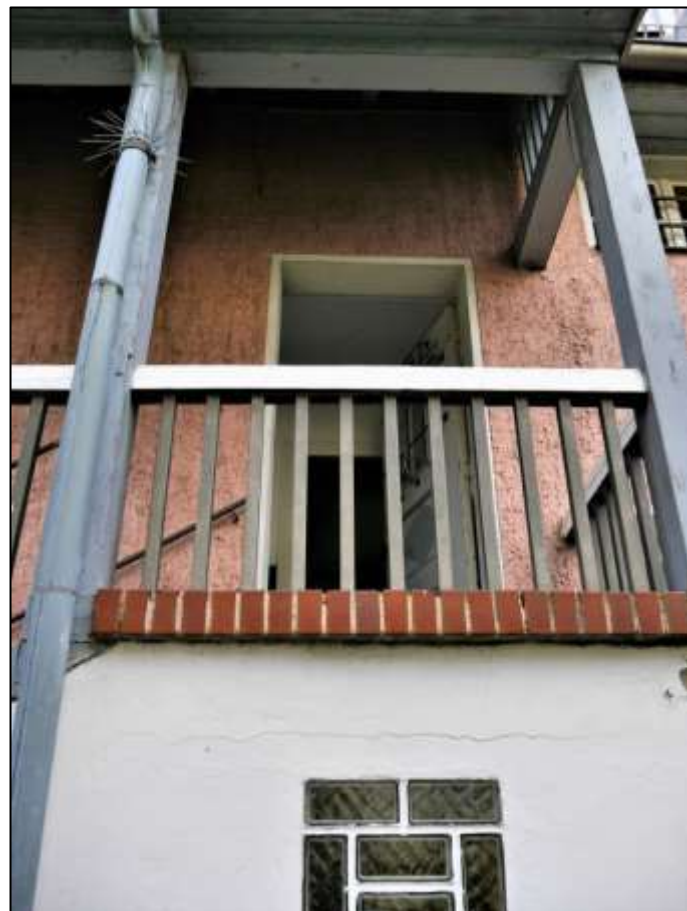
gedeckte Haus- eingangstreppe zum Hochpar- terre mit Unter- kellerung im Be- reich des Duschbade- zimmer des im Souterrain be- legenen Son- dereigentums Nr. 1 mit kräfti- gen Rissbildun- gen im Putz
