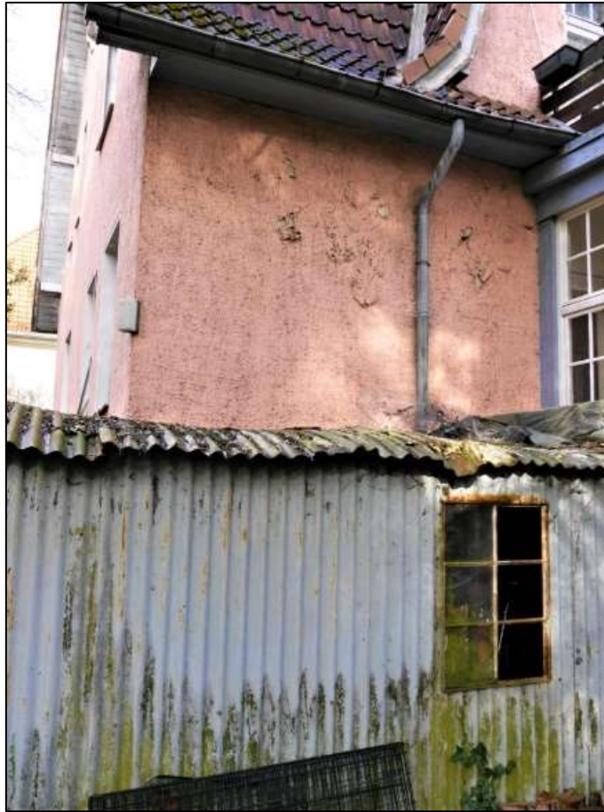
völlig verbrauchter Wellblechschuppen im linken Bauwich des Wohngebäudes und darüber aufgehende schadhafte Putzfassade des Gebäudes
