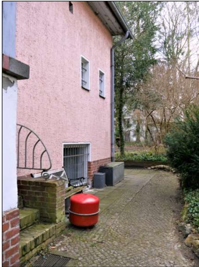
Grundstücksdurchwegung im rechten Bauwich des Wohngebäudes auf dem Grundstück Silvesterweg 9 mit links im Bild anbindender Differenzterrasse zum Nebeneingang mit anbindender Innentreppe zum Hochparterre und dem Untergeschoss und mit nachträglich eingebautem Fenster im Souterrain
