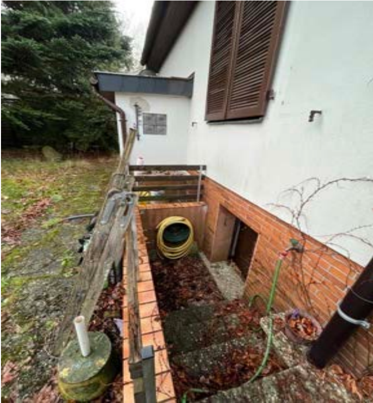
Eiskellerweg 12, Berlin - Kellerabgang
