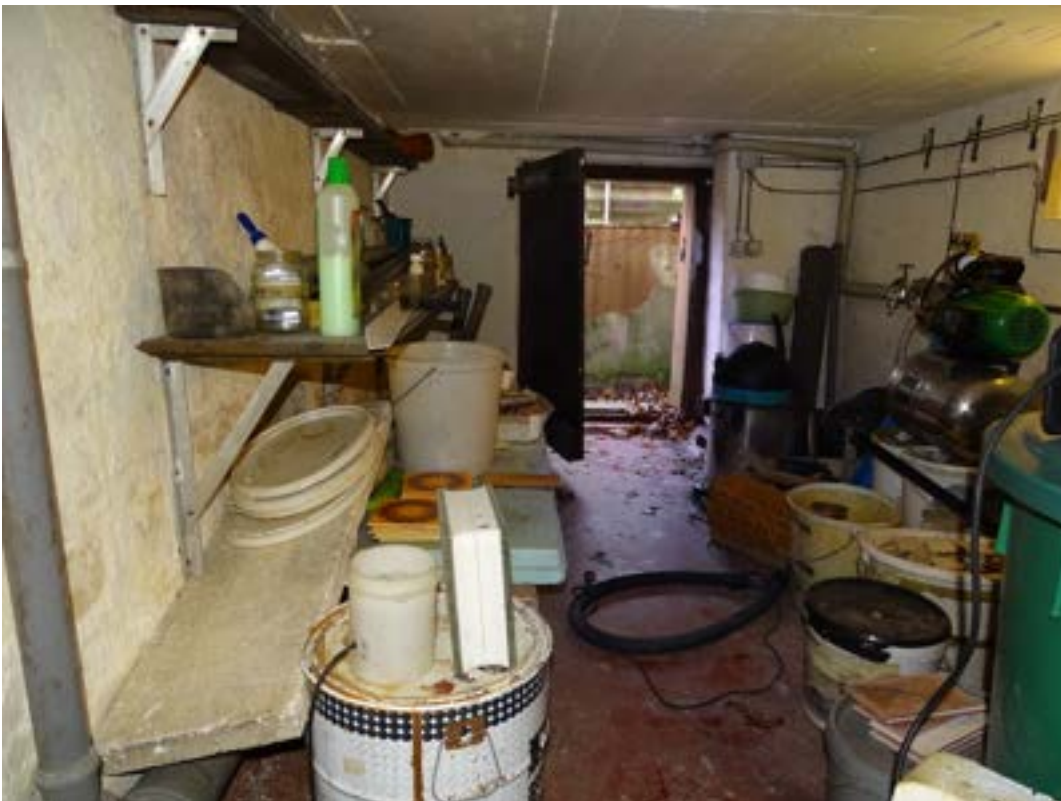
Eiskellerweg 12, Berlin - Keller
