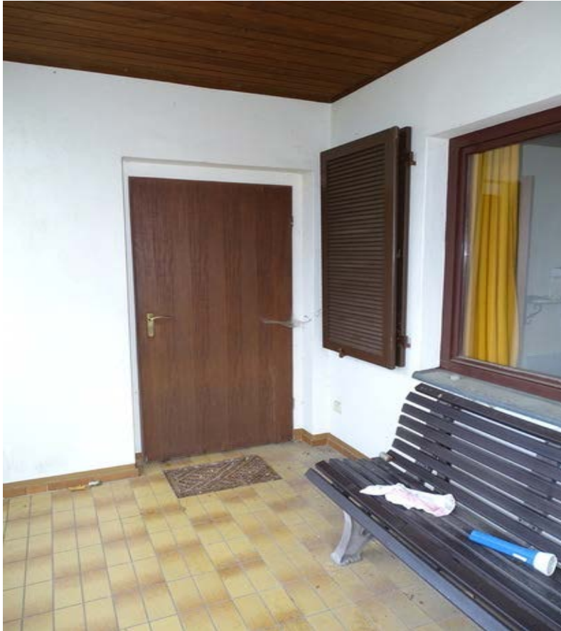
Eiskellerweg 12, Berlin - Eingang
