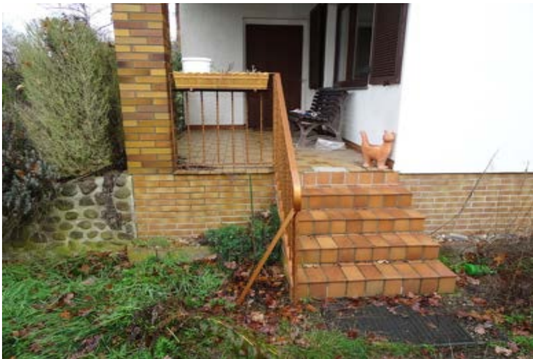
Eiskellerweg 12, Berlin - Terrassenansicht
