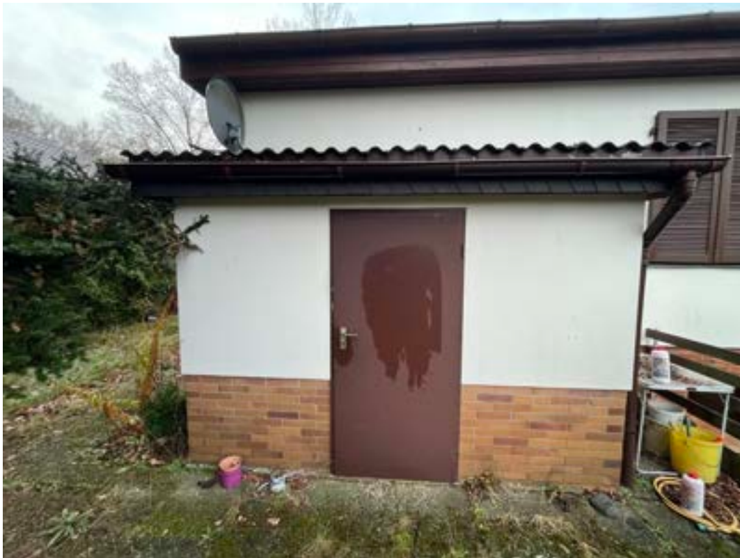
Eiskellerweg 12, Berlin – Anbau auf der Rückseite
