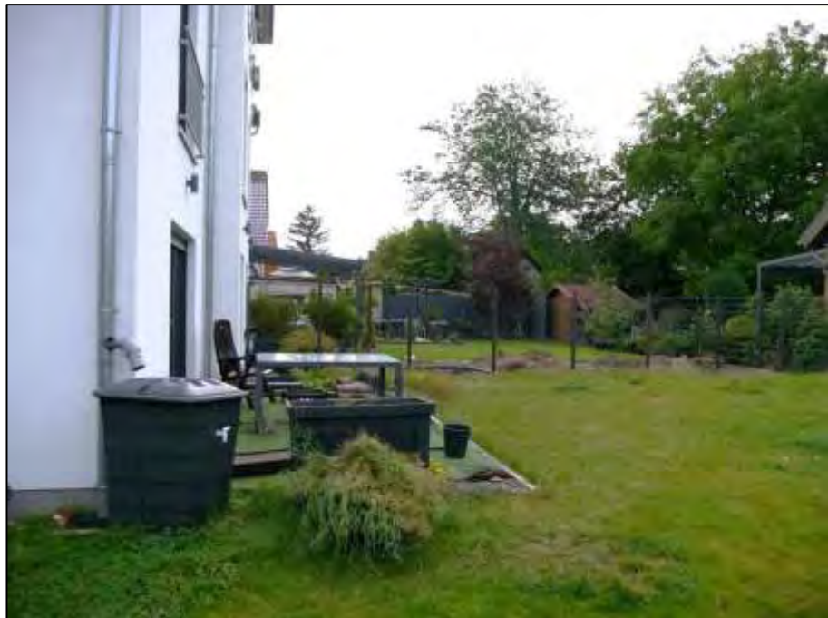
Blick auf die provisorische Gartenterrasse vor dem im Erdgeschoss belegenen Wohnzimmer der westlichen Doppelhaushälfte mit im Hintergrund anbindenden Garten der benachbarten Doppelhaushälfte a.d. Grundstück Wildganssteig 74A
