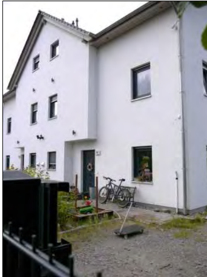
straßenseitige Hauseingangsfront Front der auf dem Grundstück Wildganssteig 74 aufstehenden rechten bzw. westlichen Einfamilien-Doppelhaushälfte im Vordergrund
