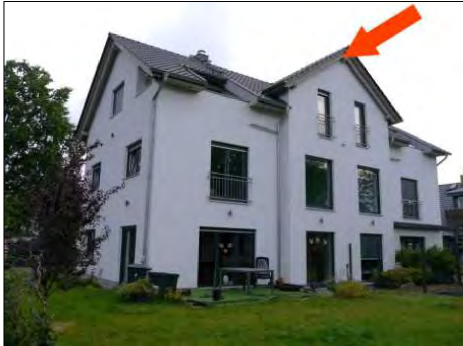
gartenseitige Gebäudefront und freie Giebelseite der westlichen bzw. im Bild linken Doppelhaushälfte a.d. Grundstück Wildganssteig 74 (Pfeil)
