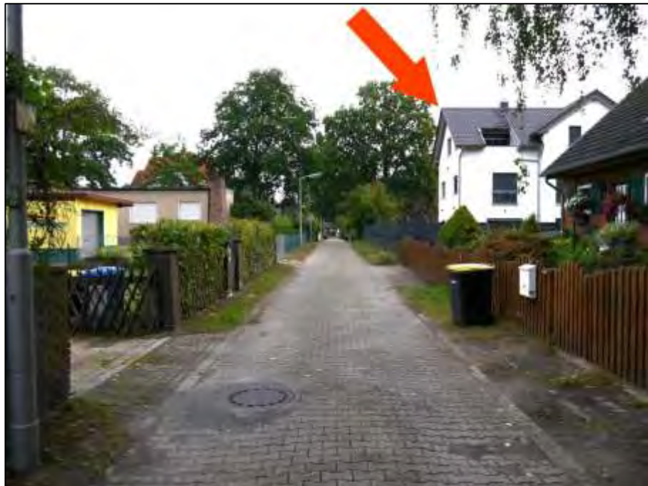
Blick in den Schneegansweg nach Norden mit Lage des Grundstücks Wildganssteig 74 auf der östlichen bzw. im Bild rechten Straßenseite mit aufstehender Einfamilien-Doppelhaushälfte (Pfeil)
