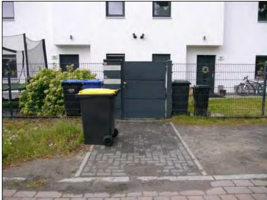
gemeinsame Zugangspforte der benachbarten Grundstücke vom Wildganssteig aus mit aufstehendem Doppelhaus und rechts im Bild anbindender Doppelhaushälfte auf dem Grundstück Wildganssteig 74
