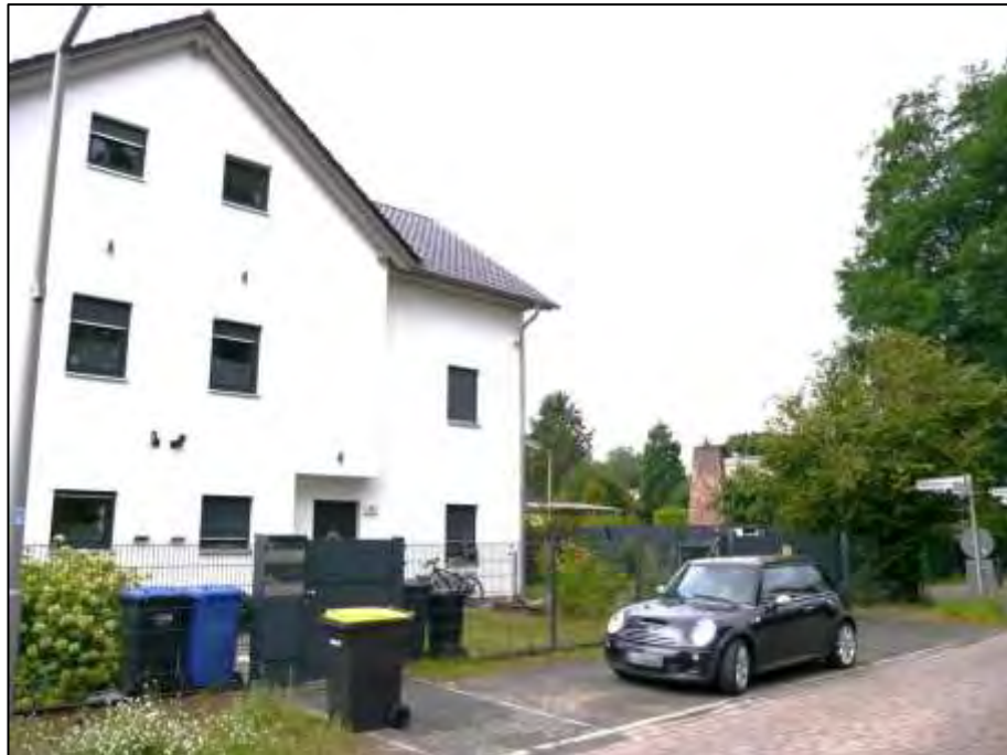
Grundstück Wildganssteig 74 mit aufstehender rechter bzw. westlicher Einfamilien-Doppelhaushälfte
