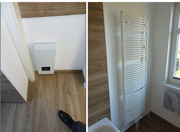
Foto 23/23a Badezimmer im OG.
