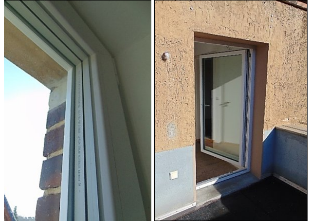
Foto 20/20a Links: Erneuerter Fenster im OG. Rechts: Balkontür im OG.
