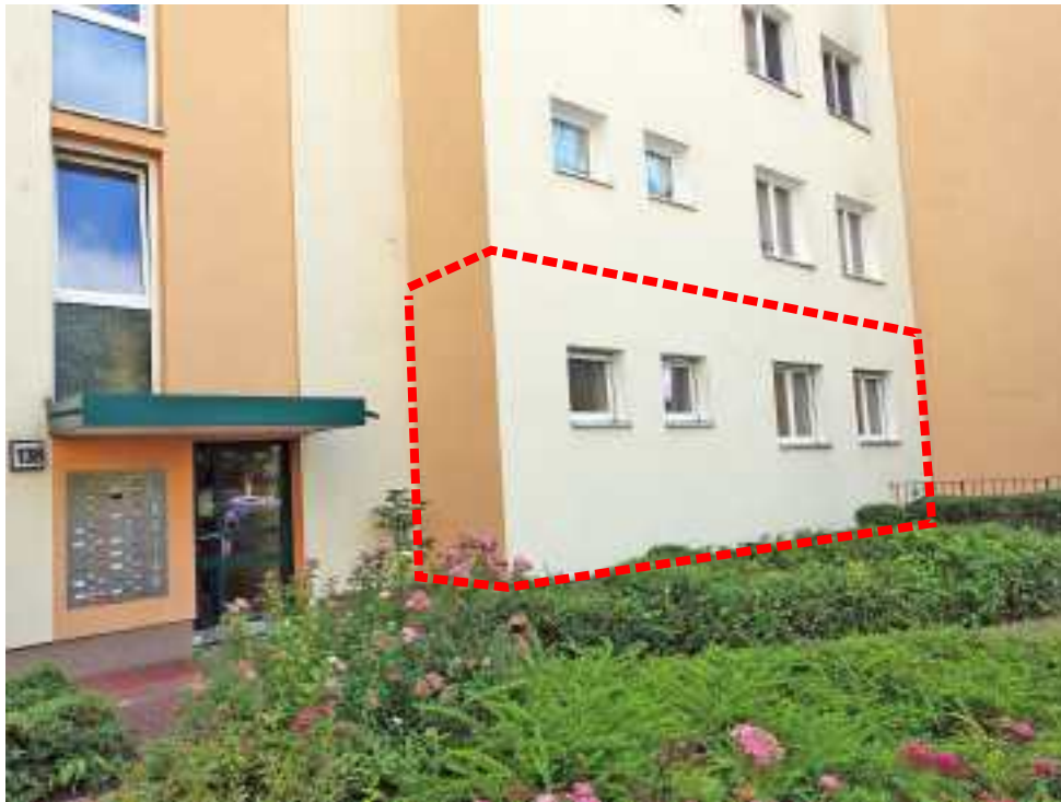
Hauseingang, die Lager der Wohnung ist markiert
