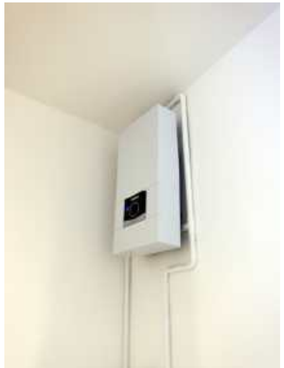
E-Durchlauferhitzer für Warmwasser
