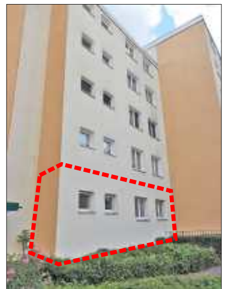
Hauseingangsseite; WE 98 markiert
