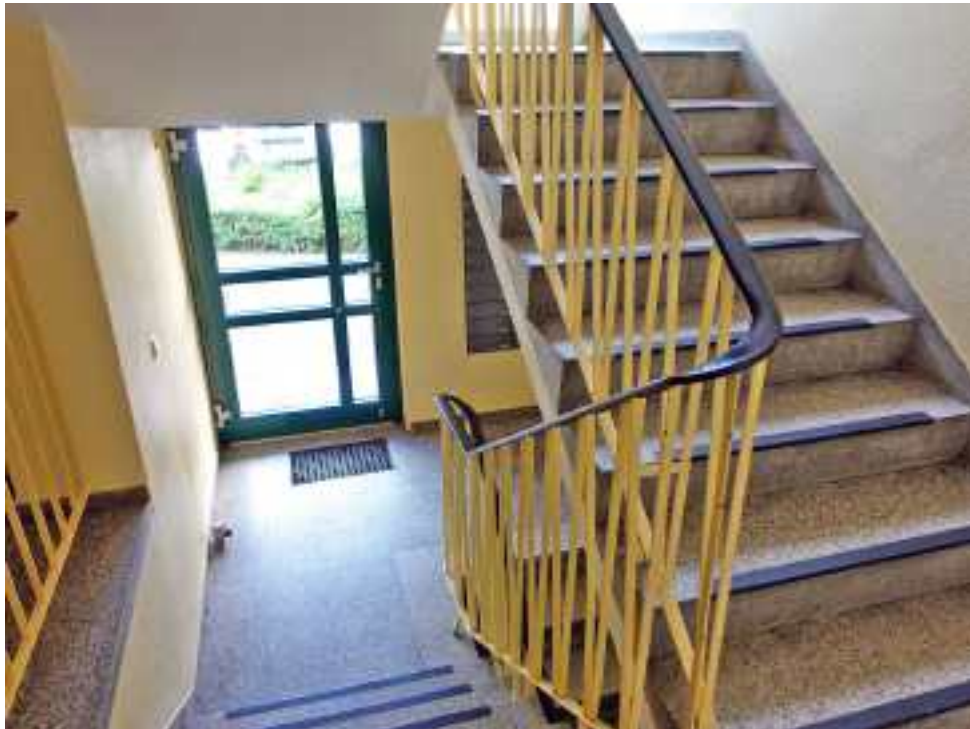
Hauseingang und Treppenhaus
