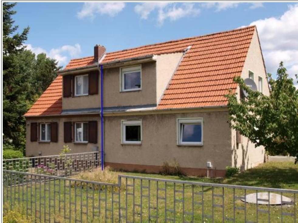
Abbildung 6: Straßenansicht aus Richtung Süden
