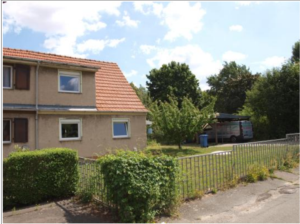
Abbildung 10: Straßenansicht aus Richtung Westen
