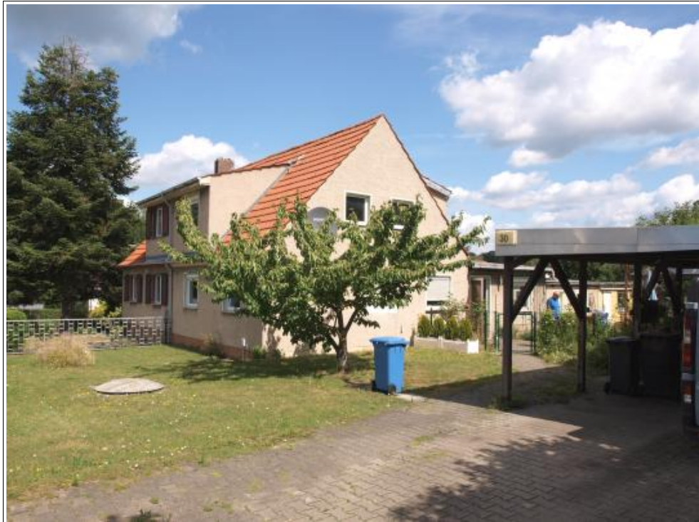
Abbildung 8: seitliche Straßenansicht aus Richtung Südost
