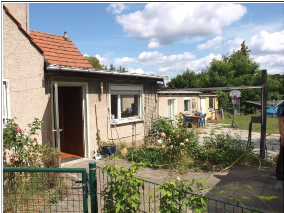
Abbildung 11: Gartenansicht aus Richtung Süden
