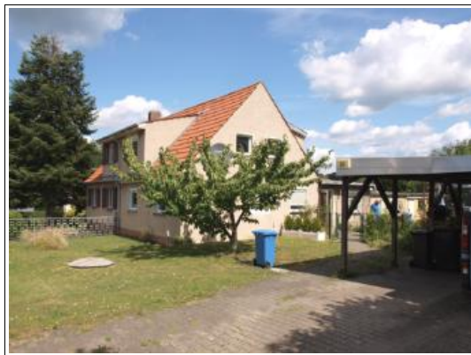
seitliche Straßenansicht aus Richtung Südost
