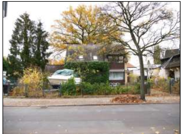
straßenseitige Front mit Blick nach Osten
