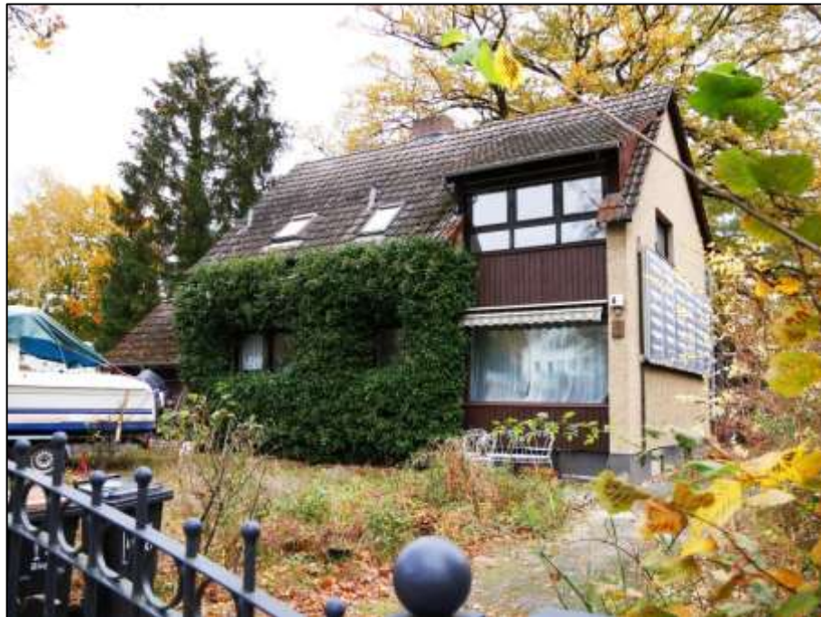
Blick über das Doppelflügeltor der südlichen Grundstücksauffahrt hinweg auf die südliche Giebelseite und die straßenseitige Gebäudefront des auf dem Grundstück Friederikestr. 49 aufstehenden Einfamilienhauses
