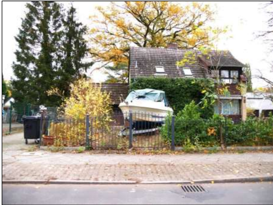
nördliche Auffahrt auf das Grundstück zu dem unterkellerten Garagen-Anbau im linken Bauwich vor der nördlichen Giebelseite des auf dem Grundstück aufstehenden Einfamilienhauses
