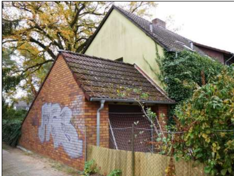
unterkellerte Grenzgarage mit Dachboden vor der nördlichen Giebelseite des Einfamilienhauses auf dem Grundstück Friederikestr. 49
