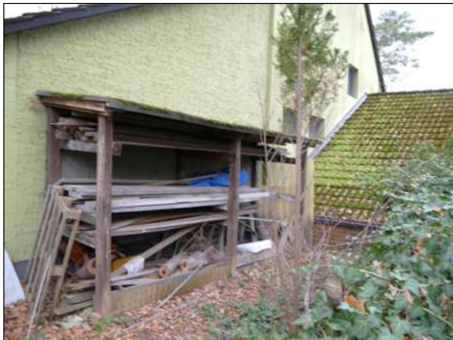
Blick aus dem Bereich der befestigten Zuwegung auf dem nördlich angrenzenden Nachbargrundstück Friederikestr. 50 als GFL-Recht für das in Hinterliegerlage belegene Grundstück Friederikestr. 50A auf die nördliche Giebelseite des Wohnhauses mit Unterstand und Grenzgarage
