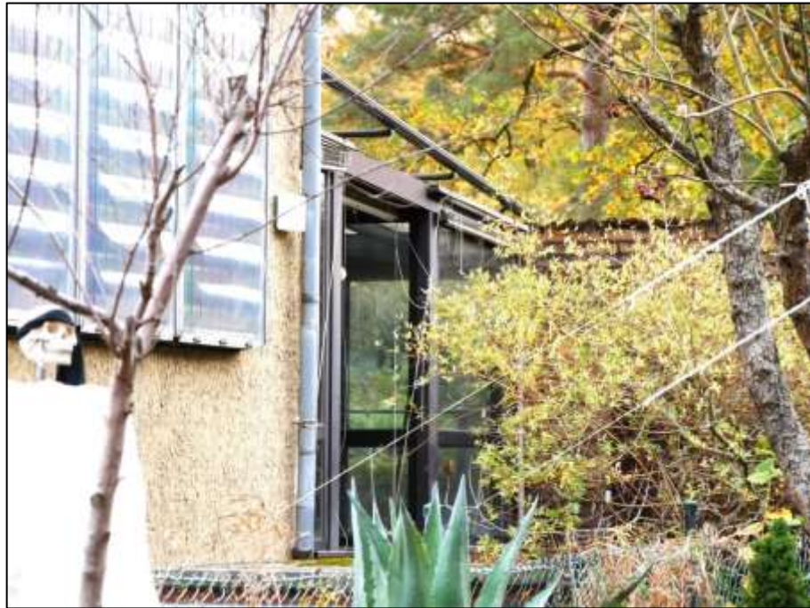
hinter der südlichen Giebelseite des Gebäudestamms anbindender Wintergarten u.a. als Zuwegungsbereich zu der in der rückwärtigen Gebäudefront belegenen Hauseingangstür
