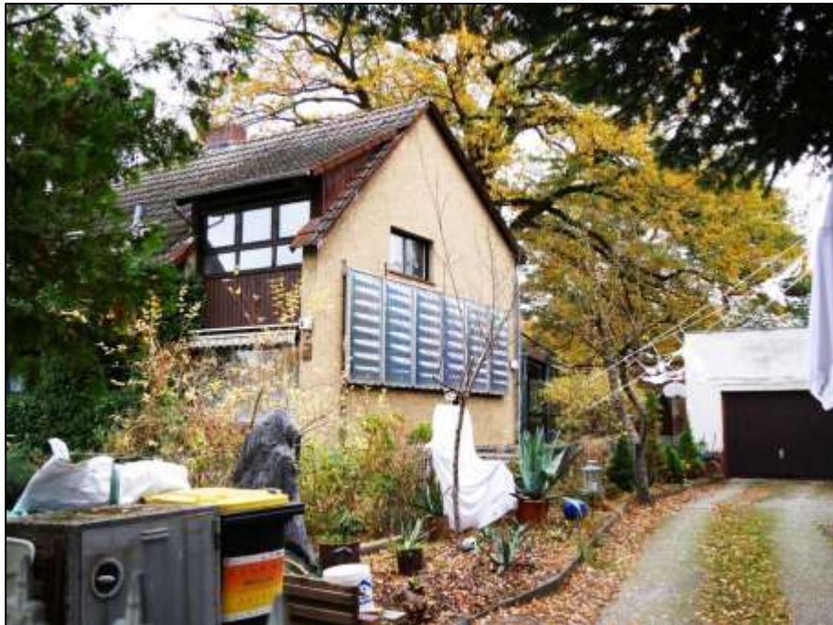
Blick über das südlich angrenzende Nachbargrundstück hinweg auf die südliche Giebelseite mit Solarthermie-Anlage des auf dem Grundstück Friederikestr. 49 aufstehenden Einfamilienhauses mit dahinter anbindendem Wintergarten
