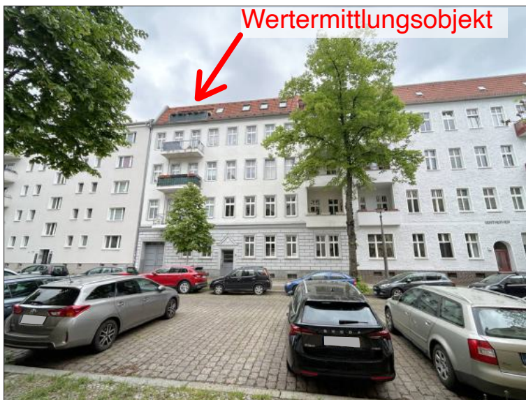
Straßenansicht; die Lage der WE 9 im Dachgeschoss ist markiert.
