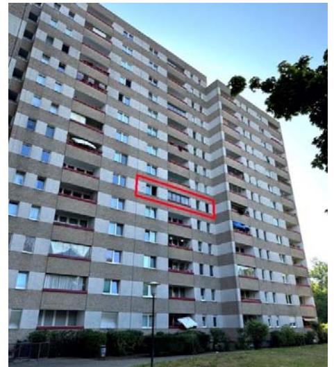
Dannenwalder Weg 90, 92 mit Kennzeichnung Sondereigentum WE Nr. 253 im 5. OG links des Hauseingangs Dannenwalder Weg 92, hinten
