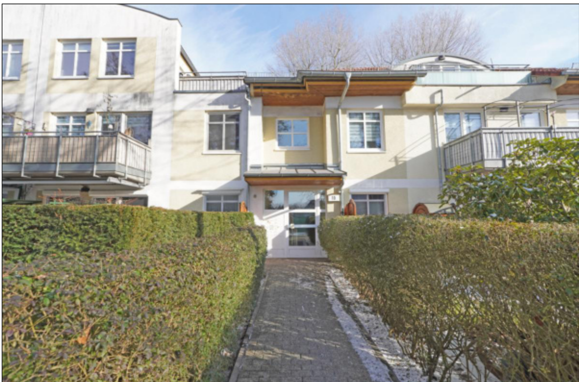
Eingangsseite des Gebäudes Am Rain 10
