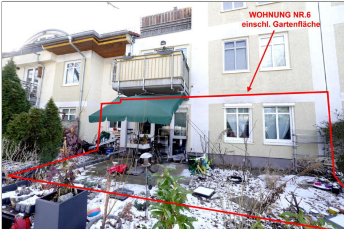
Ansicht der zu bewertenden Wohnung / Ostansicht
