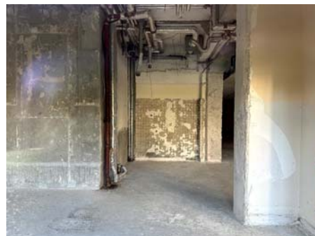
Innenansicht Sondereigentum Nr. G 3 (durch Fenster fotografiert)
