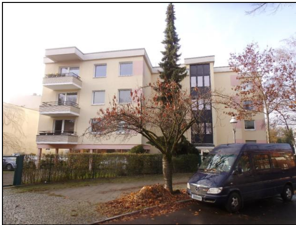
Winterstraße 8 vom Hausotterplatz
