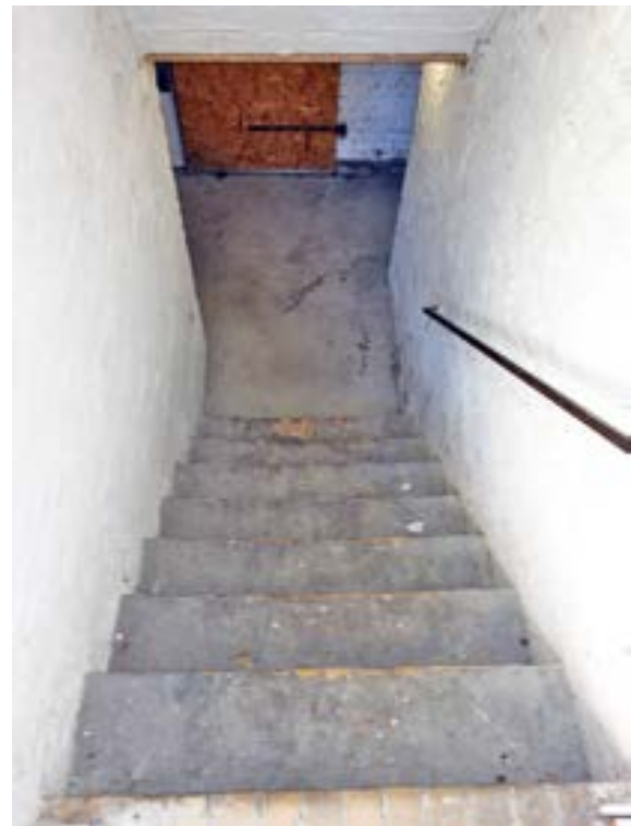
Treppe zum Kellergeschoss
