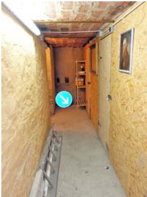
Kellergeschoss mit Kellerverschlägen
