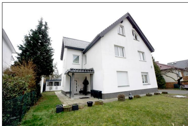
Straßenansicht inkl. nordöstlichem Nebengebäude
