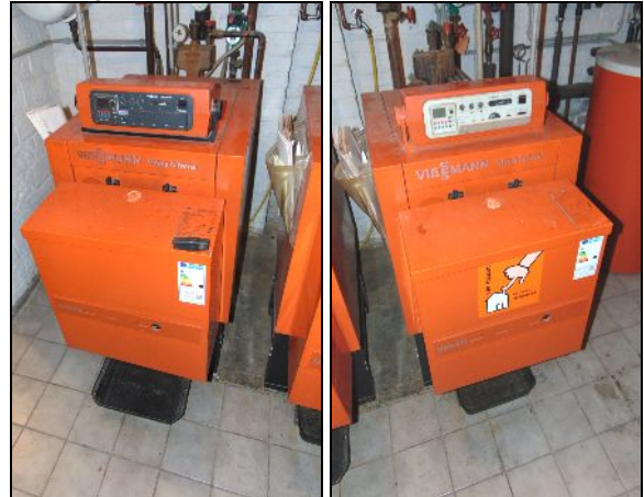
Foto 14/14a: Heizungskeller mit den beiden Heizkesseln.
