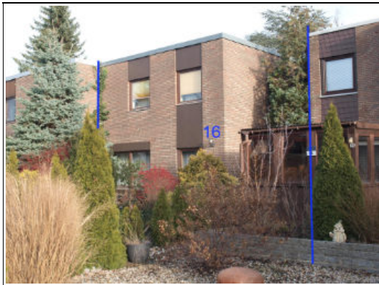
Straßenansicht aus Richtung Südwest
