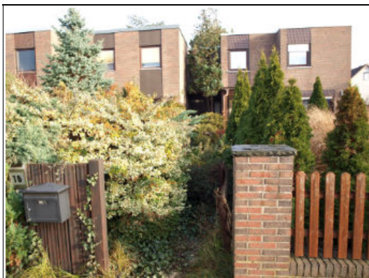
Grundstückszugang, wegen längeren Leerstand zugewachsen
