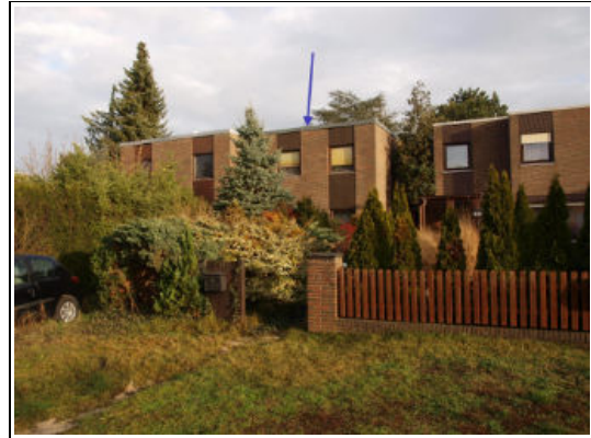
Reihenhausanlage mit 3 Häusern
