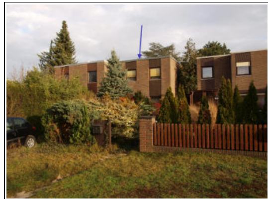
Reihenhausanlage mit 3 Häusern
