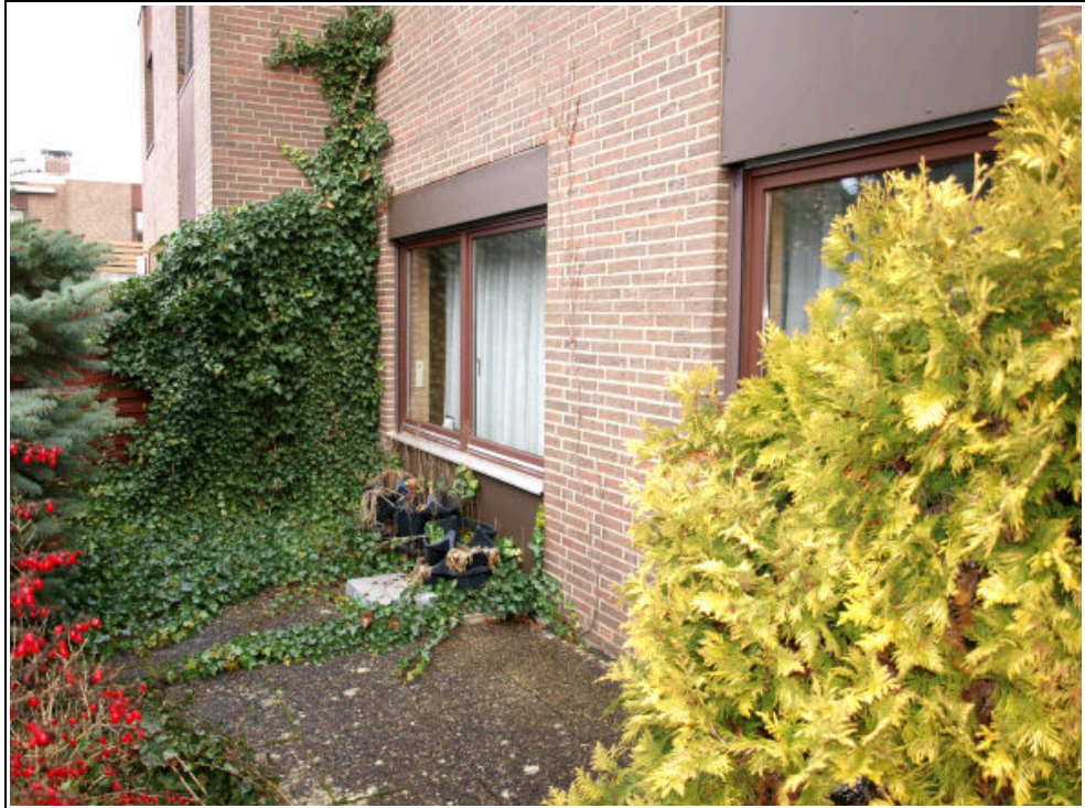
Abbildung 12: straßenseitige Teilansicht des Wertermittlungsobjektes
