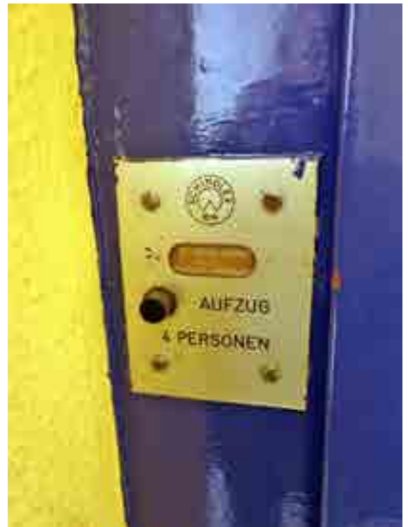
Aufzug im Treppenhaus
