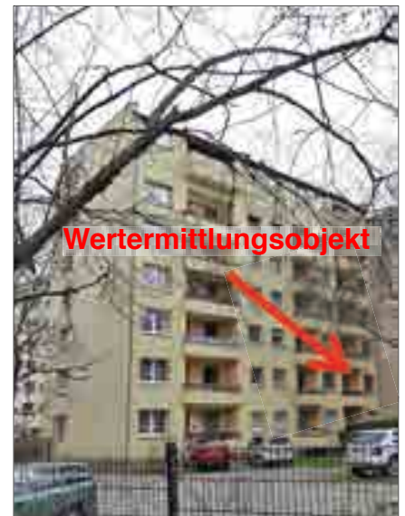
Hoffassade, Lage der WE markiert
