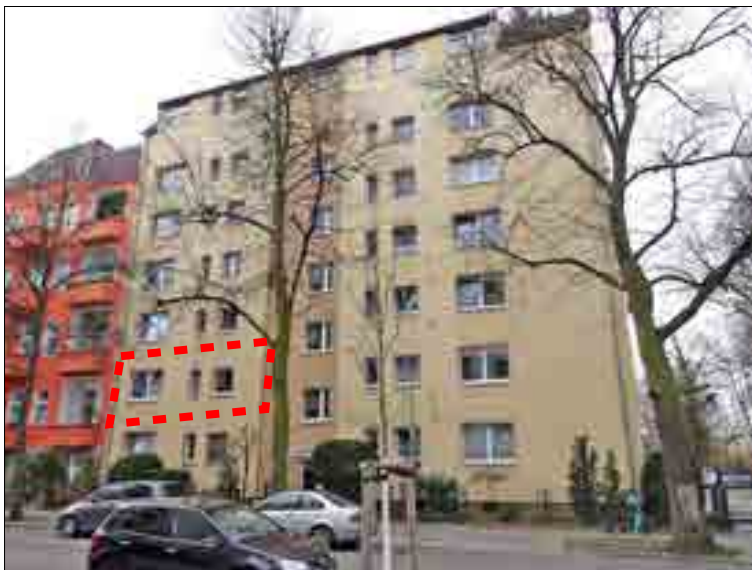
Straßenfassade, Lage der Wohnung markiert
