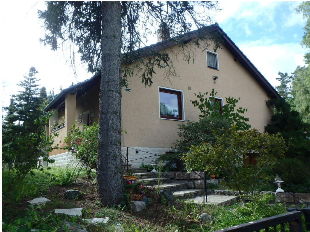
Einfamilienwohnhaus Nordostansicht (Straßenansicht)
