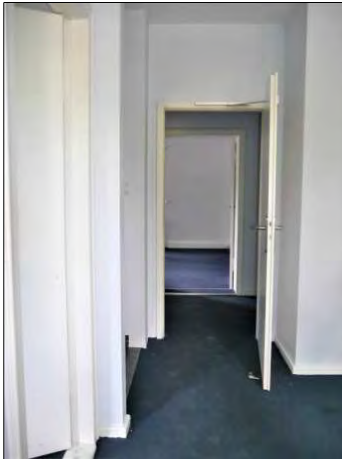
Blick aus dem Galeriebereich im Obergeschoss auf die Zugangstür des anbindenden Flurs mit dahinter zum linken Bauwich orientierten Büro- raum
