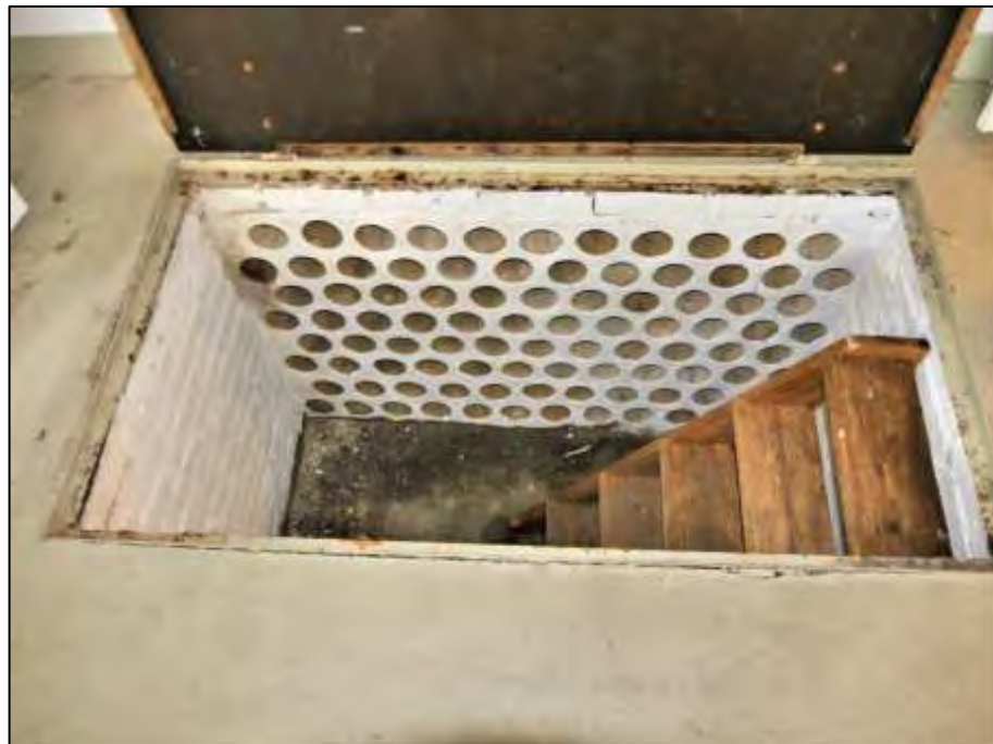
in die Raumsohle eingesenkter Weinlagerschacht mit massivem Röhren-Weinlager und Holzplattenabdeckung als Bodenluke
