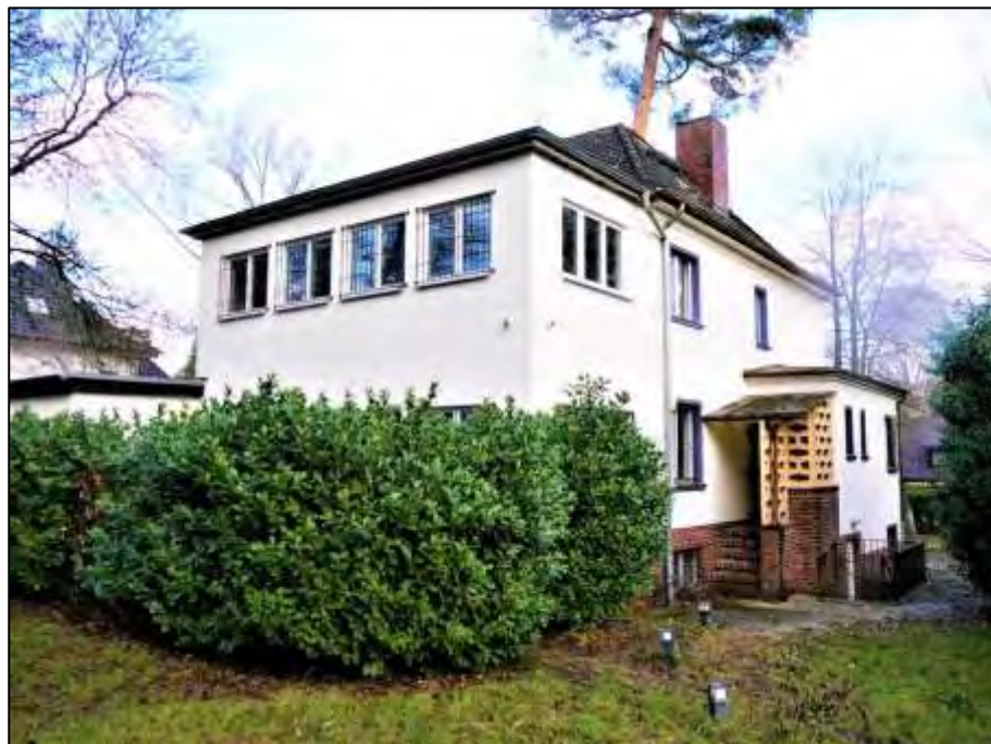
Blick nach Nord-Westen auf die gartenseitige nach Süden und die zum linken Bauwich nach Osten orientierten Gebäudefronten
