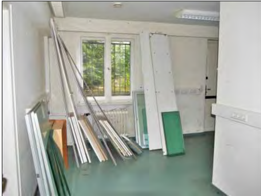
zum rechten Bauwich orientierter Kellerraum mit Zugangstür aus dem Bereich der Garagenrampe
