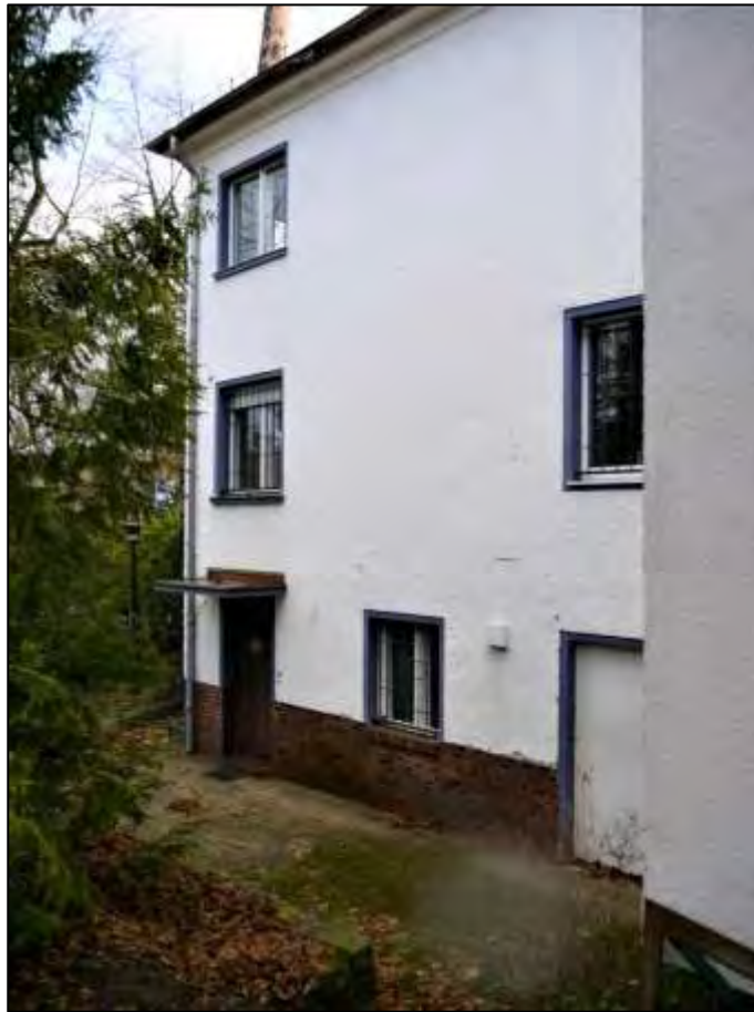
Blick von der Böschungskrone zu dem westlichen Nachbargrundstück auf die westliche Giebelseite des ehemaligen Wohn- und nunmehr Bürogebäudes mit Nebeneingängen im Unter- bzw. Kellergeschoss
