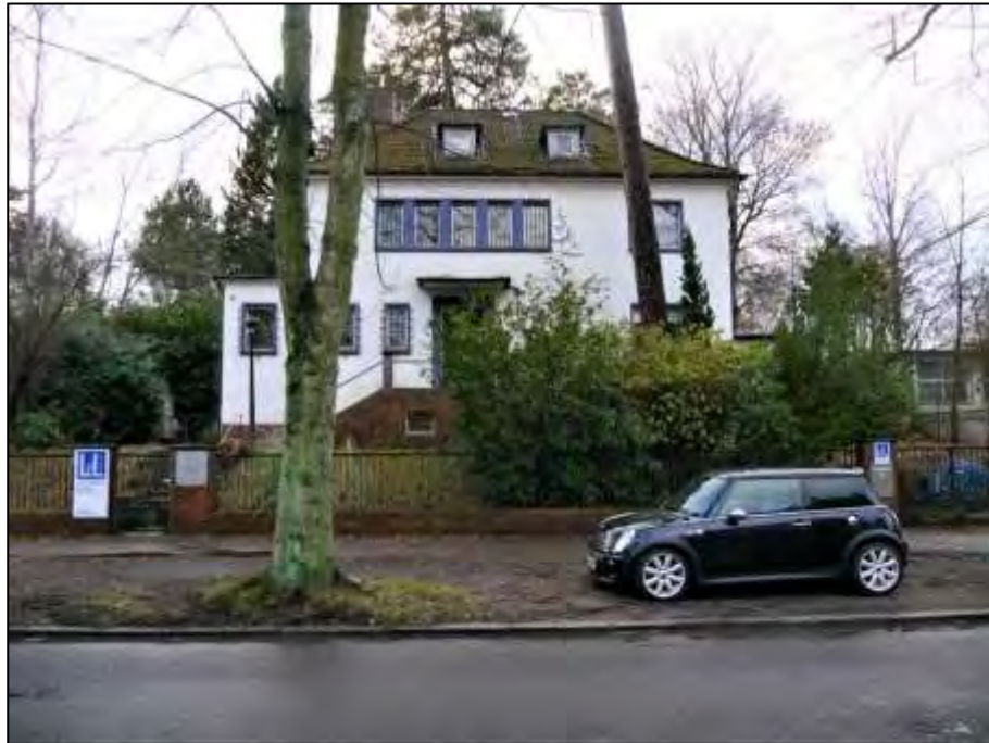
straßenseitige Front des Grundstück Maximiliankorso 63
