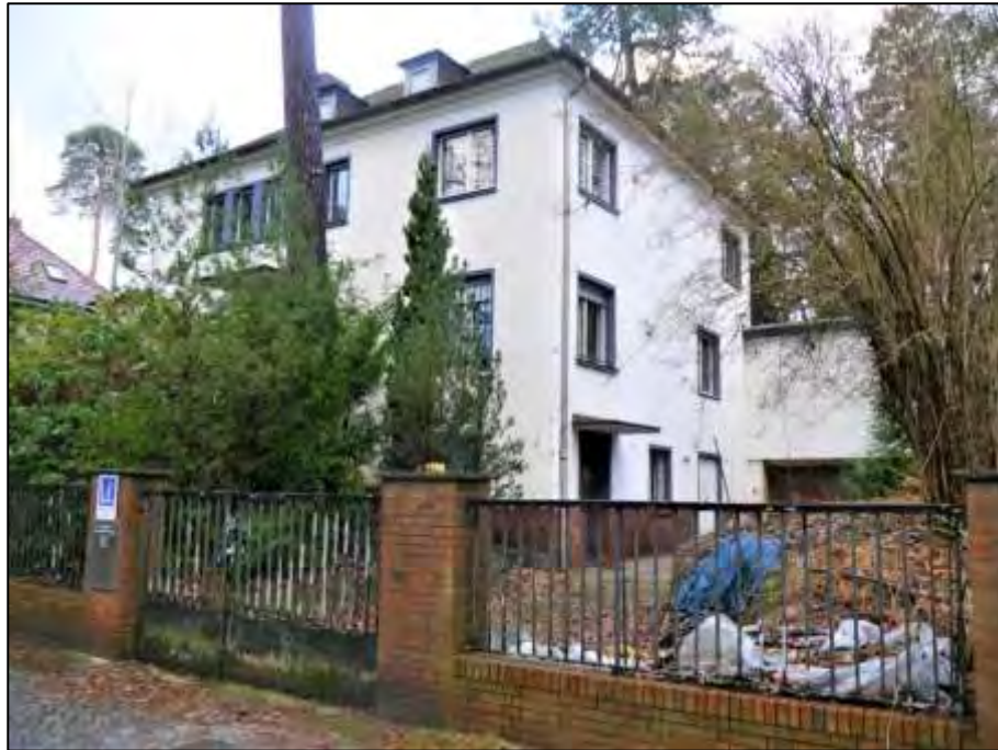
Blick über die straßenseitige Einfriedung des Grundstücks Maximiliankorso 63 auf die straßenseitige Front und die westliche Giebelseite des auf dem Grundstück aufstehenden Gebäudes sowie Garagen-Anbau mit Aufstockung als Bürofläche rechts im Bild
