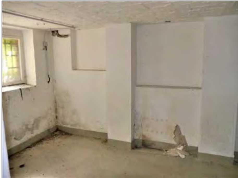
zum linken Bauwich orientierter höher liegender Kellerraum
