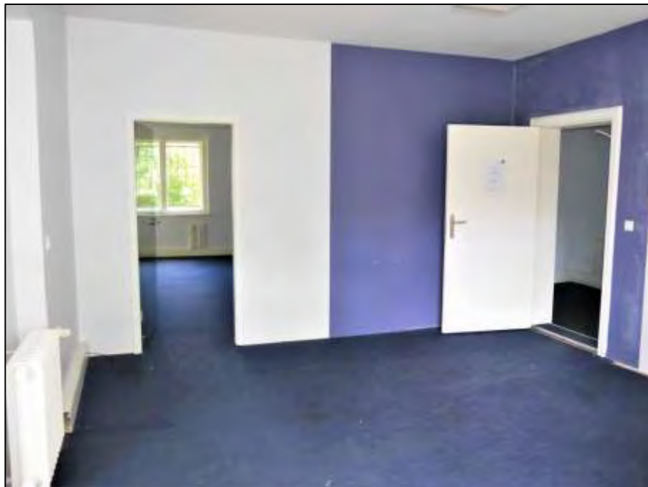
im OG links im Flur zum linken Bauwich orientierter Büroraum mit Zugang aus dem Flur rechts und zum rechten Bauwich orientiertes Büro
