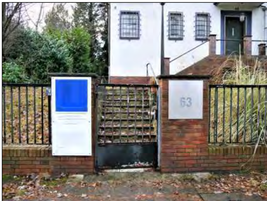
Zugangspforte der Hauszuwegung in der straßenseitigen Einfriedung des Grundstücks Maximiliankorso 63 mit anbindender Differenzterrasse
