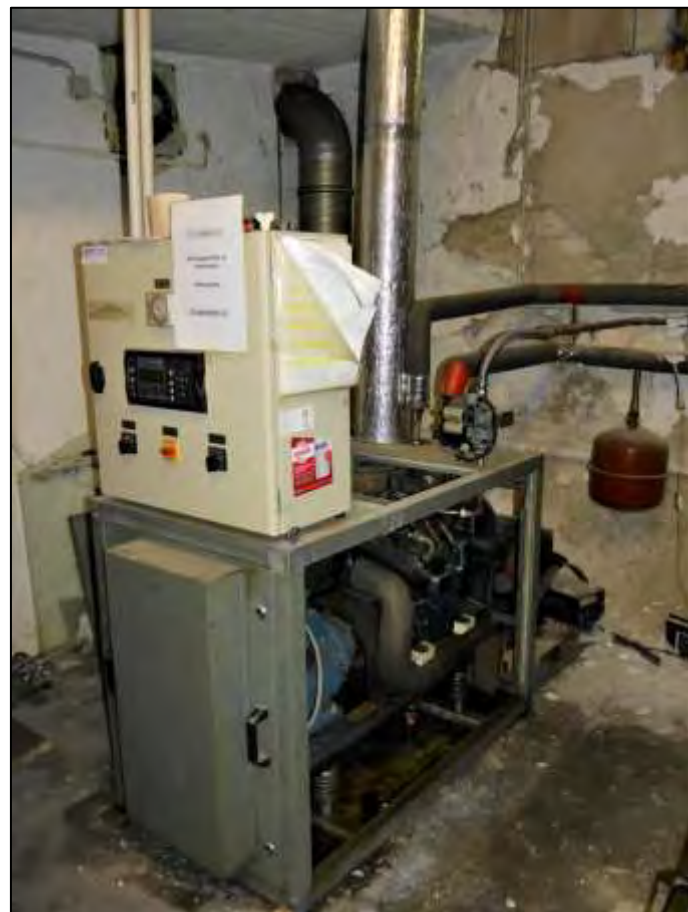
Heizkessel des ehemals betrie- benen Block- heizwerks
