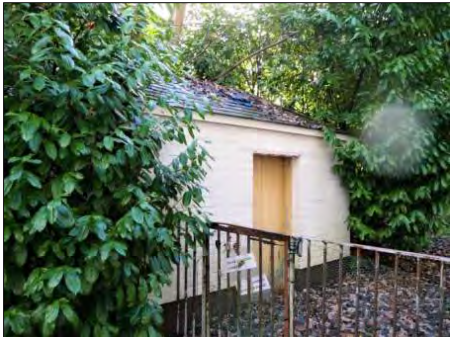
vor der östlichen Grundstücksgrenze im linken Bauwich belegener Massivschuppen vermtl. als Geräteschuppen o.ä.
