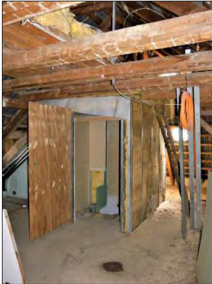
Rohdachboden mit allenfalls erst partiell eingehauem Zugang über die Deckenöffnung als Bodenluke für die Anstellleiter mit provisorischer OSB-Plattentür
