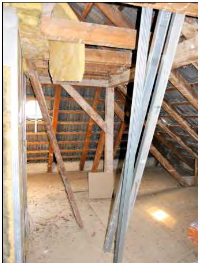
Rohdachboden ohne raumbildenden Ausbau
