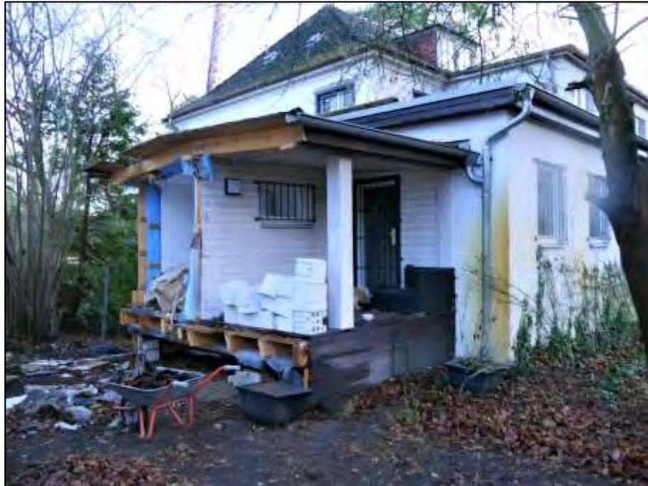
Blick nach Nord-Osten auf die gartenseitige nach Süden und die zum rechten Bauwich nach Westen orientierten Gebäudefronten mit Garagen-Aufstockung und teilabgebrochenem hölzernem Verbindungsbau im Vordergrund
