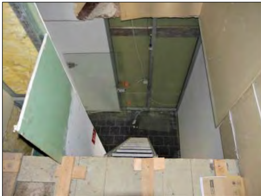
Blick aus dem Dachboden in die Deckenöffnung als Bodenluke für die mobile Anstallleiter in der innenliegenden Kammer im Obergeschoss
