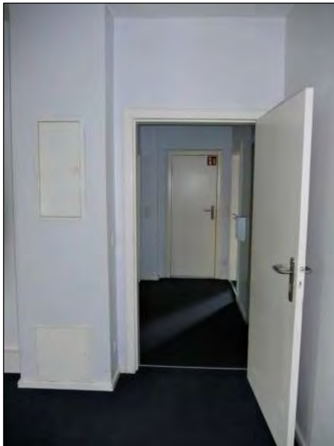
Blick aus dem straßenseitigen und zum rechten Bauwich orientierten Büroraum (Besprechung lt. Plan) im Obergeschoss in den Flur mit an der rückwärtigen Stirnseite belegener Zugangstür in die innenliegende Kammer mit Anstellleiter zum Dachbodenausstieg
