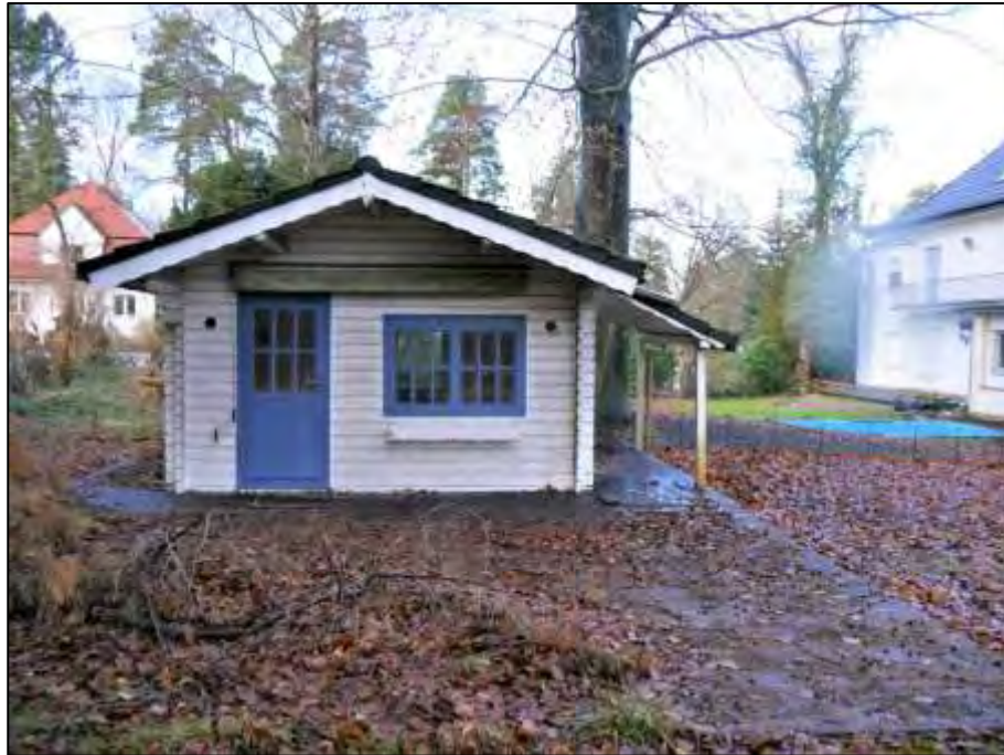
in der süd-westlichen Grundstücksecke belegenes hölzernes Gartenhaus
