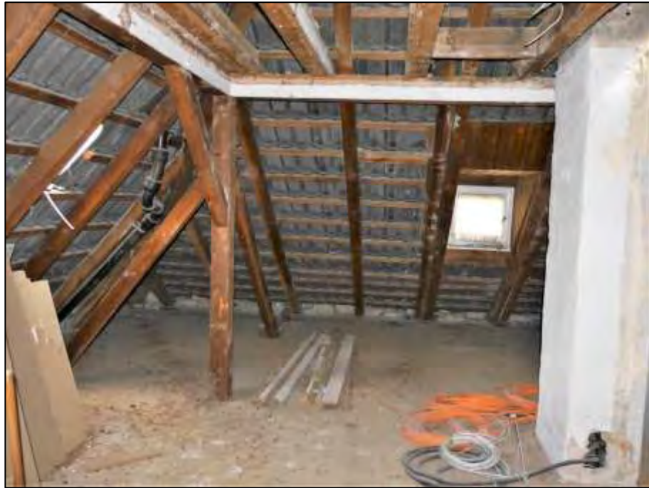
Rohdachboden ohne raumbildenden Ausbau
