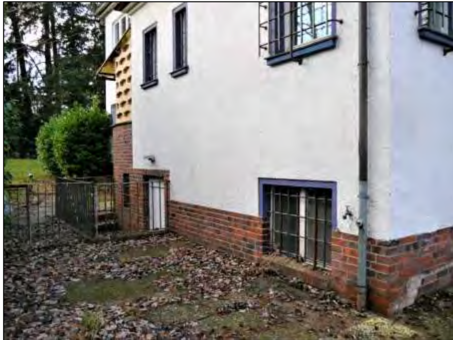
zum linken Bauwich nach Osten orientierte Gebäudefront im Bereich des 1-geschossigen gleichfalls unterkellerten Vorbaus mit davor belegener Kelleraußentreppe und dahinter anbindendem weiterem Gebäudeeingang zum Hochparterre
