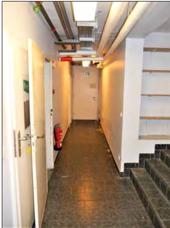
2-hüftiger zentraler Kellerflur mit Kelleraußentür zur Kelleraußentreppe im Hintergrund sowie Differenz- treppe im Vordergrund rechts zu 2 höher liegenden Keller- räumen
