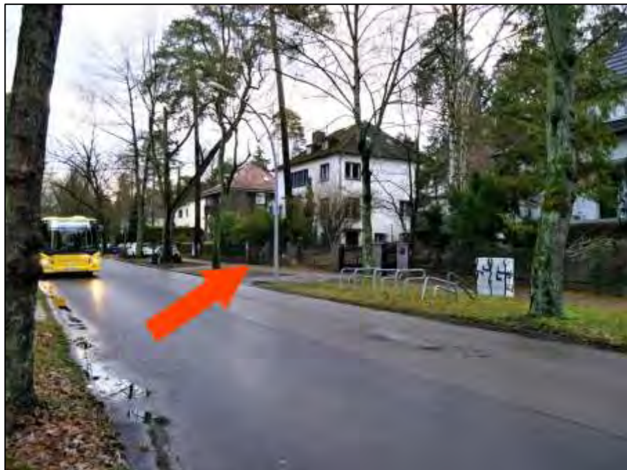
Blick über den Maximiliankorso nach Süd-Osten mit Lage des Grundstücks Maximiliankorso 63 auf der südlichen bzw. im Bild rechten Straßenseite (Pfeil)
