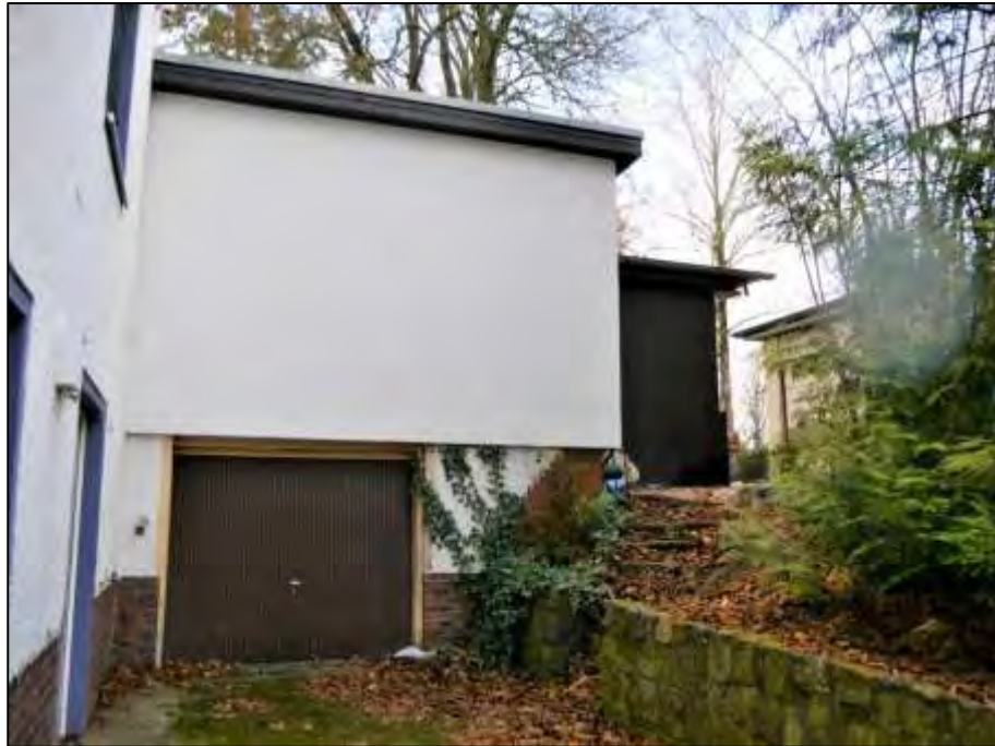
Blick aus der Garagenzufahrt auf den Garagen-Anbau mit Aufstockung als Bürofläche sowie verbliebener Rest eines teilabgerissenen hölzernen Verbindungsbaus zu dem westlich angrenzenden Nachbargrundstück
