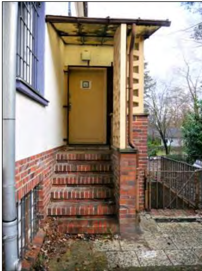
rückwärtige Stirnseite des zum linken Bauwich orientierten 1-geschossigen Vorbaus des Gebäude- stamms mit rückwärtigem Gebäudeein- gang zum Hochparterre
