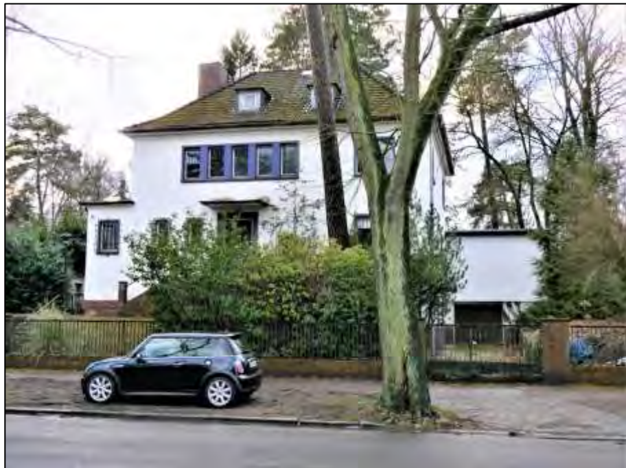
straßenseitige Front des Grundstück Maximiliankorso 63 mit Straßenbaum im Luftraumprofil der Garagenzufahrt aus dem Straßenraum
