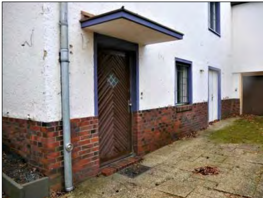
Nebeneingänge aus dem Bereich der Garagenzufahrt in der westlichen Giebelseite des ehemaligen Wohn- und nunmehr Bürogebäudes
