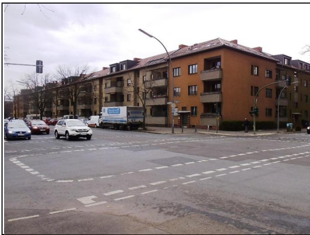
Ecke Holzhauser Straße, Miraustraße
