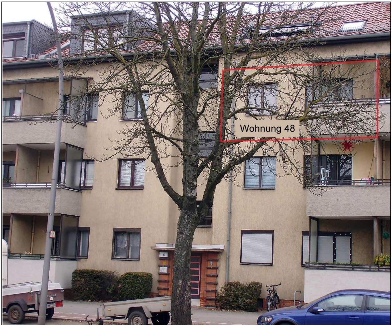
Ansicht Holzhauser Straße 113 (Die Lage der Wohnung Nr. 48 wurde gekennzeichnet.)
