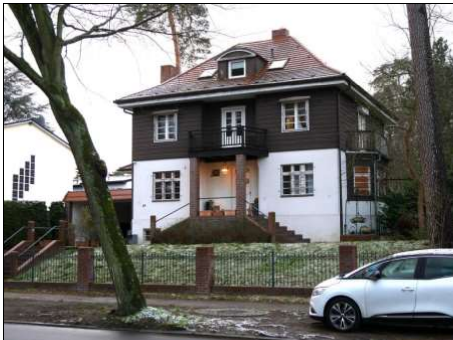
straßenseitige Front sowie zum rechten Bauwich orientierte Giebelseite der auf dem Grundstück Maximiliankorso 64 aufstehenden Altbau-Villa
