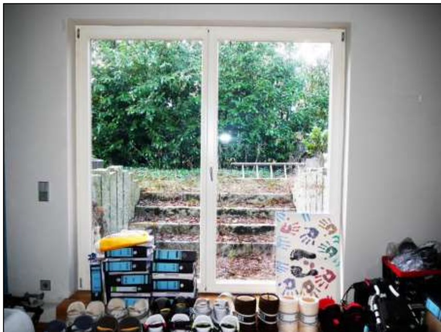
in der südlichen Giebelseite der früheren Gymnastikhalle belegene Fens- tertür mit davor aufgehender Außentreppe zum höheren Garten-Niveau
