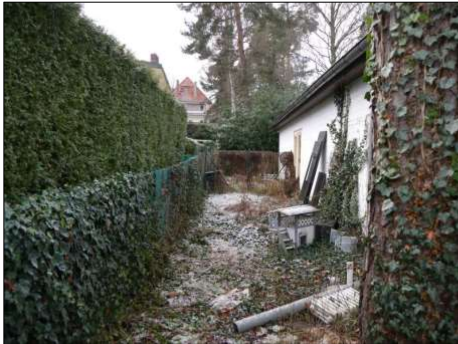
Blick in den linken Bauwich der Gymnastikhalle in Richtung der rückwärtigen Grundstücksgrenze
