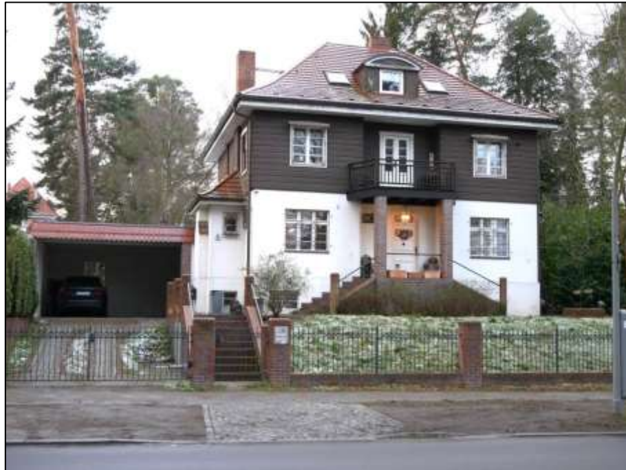
straßenseitige Front des Grundstücks Maximiliankorso 64 mit überholter Gehwegüberfahrt nebst Bordschwellenabsenkung auf Höhe der Zugangspforte in der Einfriedung ohne Bordschwellenabsenkung und Gehwegüberfahrt zur Rampe des Doppel-Carports und Hauseingangsfront der auf dem Grundstück aufstehenden Altbau-Villa mit Doppel-Carport im linken Bauwich
