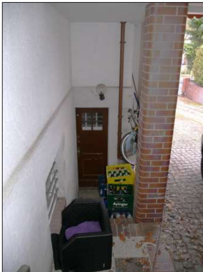
aus dem gedeckten Bereich des Doppel-Carports zugängliche Kelleraußentür mit davor belegener Kelleraußentreppe der straßenseitigen Altbau-Villa
