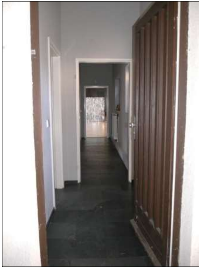
Blick aus dem gedeckten Bereich des Doppel-Carports durch die Türöffnung der Hauseingangstür der früheren Gymnastikhalle in den einhüftigen Flur vor der westlichen Außenfront mit im Hintergrund anbindendem Wohn-/Esszimmer mit Küchenbereich
