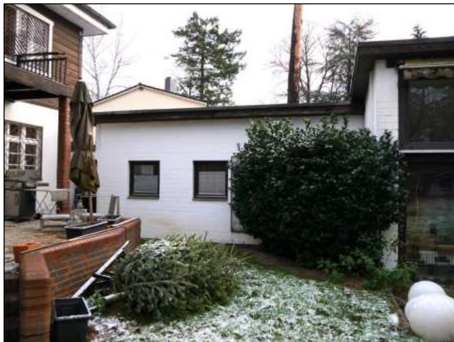
hinter der gartenseitigen Gebäudefront der Altbau-Villa belegene Terrasse mit anbindender ehemaliger Gymnastikhalle als Wohngebäude
