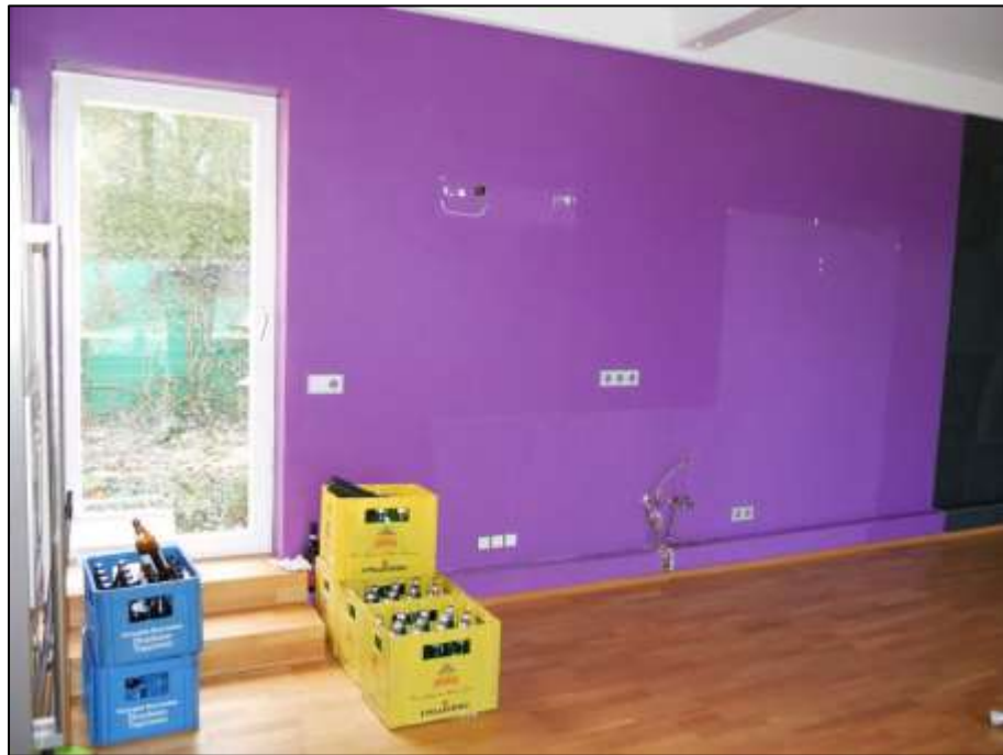
Wohn-/Esszimmer mit Anschlüssen für eine Küchenausstattung der in der früheren Gymnastikhalle belegenen Nutzungseinheit
