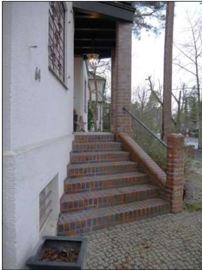
Hauseingangstreppe der straßenseitigen Altbau-Villa
