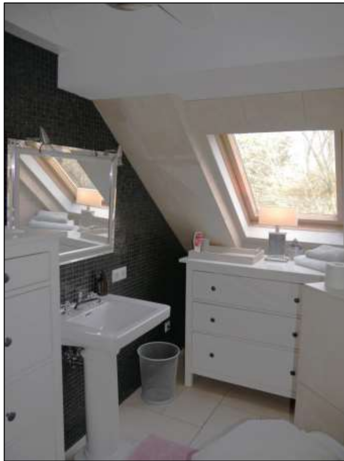
Duschbadezimmer im Dachraum-Ausbau mit Säulenwaschtisch und straßenseitig liegendem Holz-Isolierglasfenster
