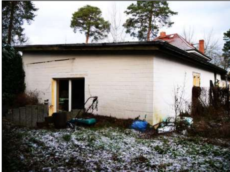
südliche Giebelseite und östliche Front der vor der östlichen Grundstücksgrenze im rückwärtigen Grundstücksteil errichteten ehemaligen Gymnastikhalle mit Nutzung nunmehr als Wohnhaus
