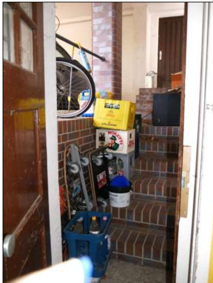
Blick durch die Kelleraußentür auf die im Bereich des Doppel-Carports belegene Außentreppe der Altbau-Villa
