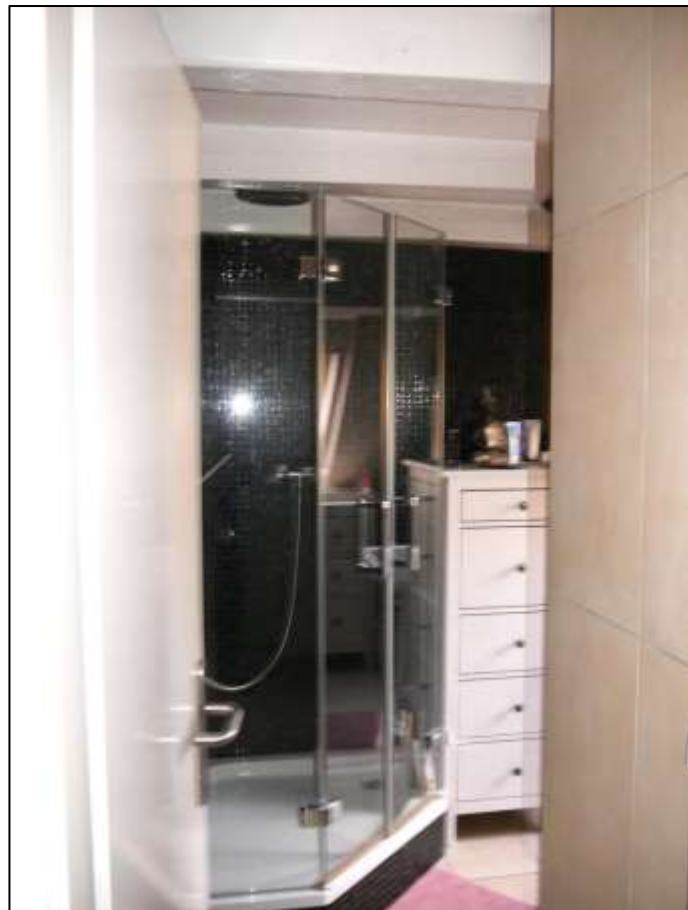
Duschbadezimmer im Dachraum-Ausbau mit Flachduschtasse
