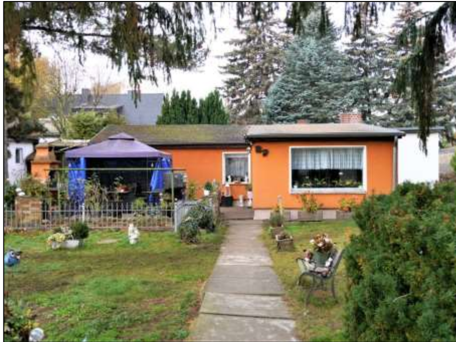
Blick über die zur Straße Am Schmeding orientierte straßenseitige Einfriedung bzw. die Zugangspforte auf die straßenseitige Front des auf dem Eckgrundstück Am Schmeding 17, Hagebuttenhecke 7 (Flurstück 48) aufstehenden Einfamilienhauses
