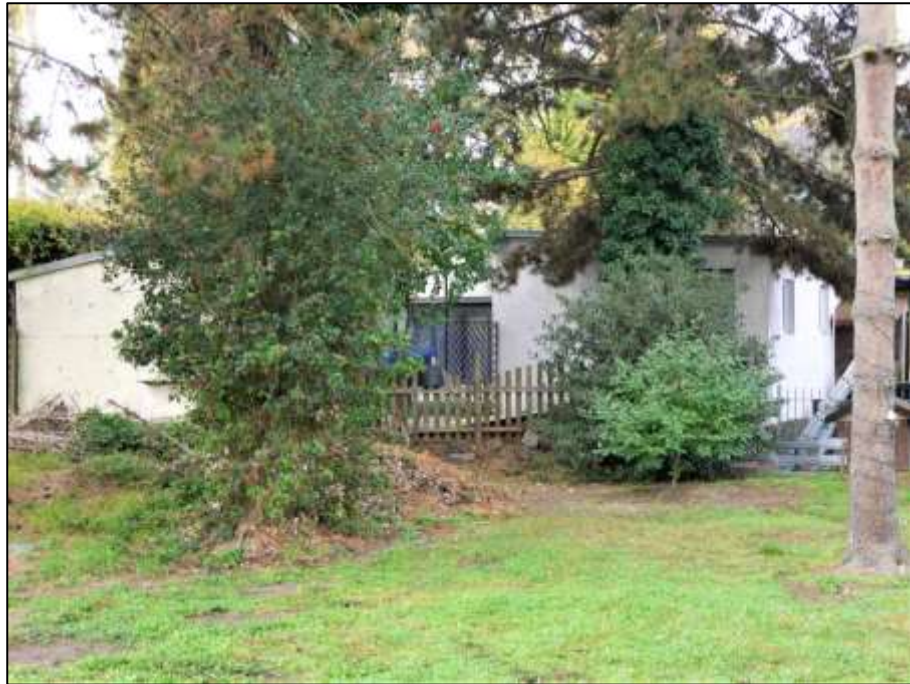
Blick über die zur Straße Am Schmeding orientierte straßenseitige Einfriedung auf den im Bild rechts belegenen Küchen-Anbau an den Imbissstand sowie Imbissstand mit straßenseitigem Wintergarten-Anbau und Toilettenhäuschen im Vordergrund links (v.r.n.l.)
