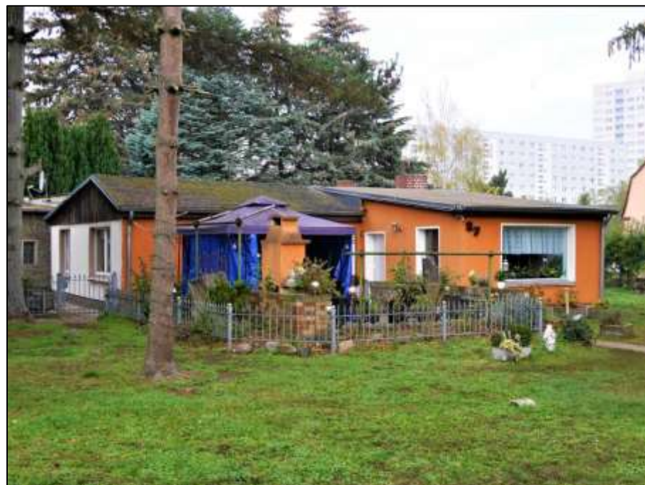
Blick über die zur Straße Am Schmeding orientierte straßenseitige Einfriedung auf die zum linken bzw. süd-westlichen Bauwich orientierte Giebelseite sowie die straßenseitige Front des auf dem Eckgrundstück aufstehenden Einfamilienhauses
