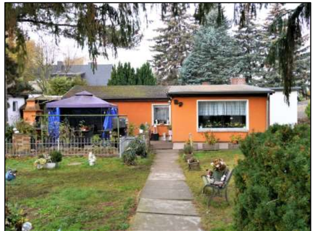
straßenseitige Front des Einfamilienhauses
