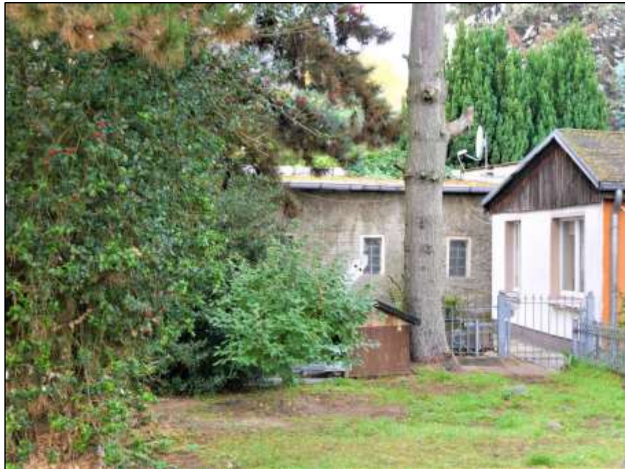
Blick über die zur Straße Am Schmeding orientierte straßenseitige Einfriedung auf die linke Giebelseite des Einfamilienhauses rechts im Bild und einem dahinter belegenem Teil der Nebengebäude mit Grenzgaragen-Erweiterung
