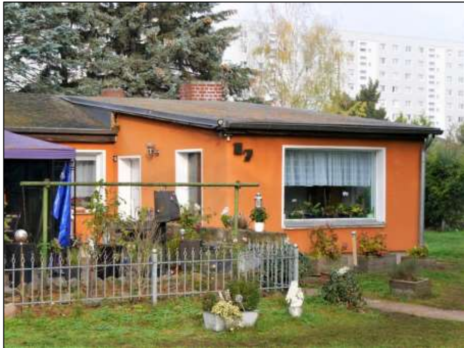
Blick über die zur Straße Am Schmeding orientierte straßenseitige Einfriedung auf die zum linken bzw. süd-westlichen Bauwich orientierte Giebelseite sowie die straßenseitige Front im Bereich des straßenseitigen Vorbaus mit zur Terrasse orientierter Hauseingangstür des auf dem Eckgrundstück aufstehenden Einfamilienhauses
