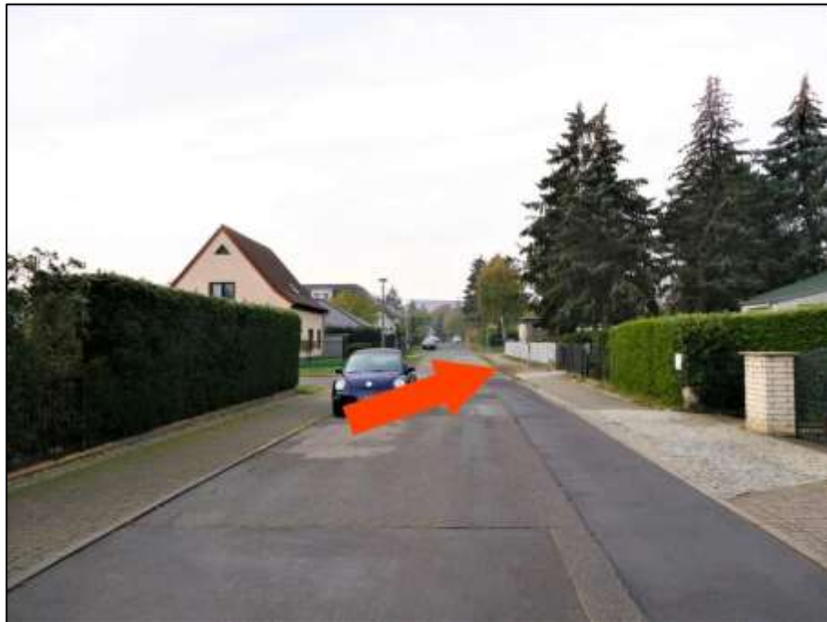
Blick in die Straße Am Schmeding nach Süd-Westen mit Lage des Eckgrundstücks Am Schmeding 17, Hagebuttenhecke 7 (Flurstück 48) auf der nord-westlichen bzw. im Bild rechten Straßenseite (Pfeil)
