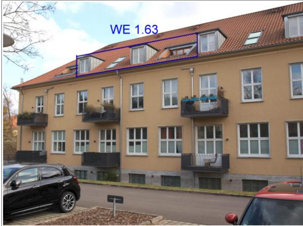
Abbildung 7: straßenseitige Ferdinand-Magellan-Straße 38 mit SE Nr. 1.63 im Dachgeschoss
