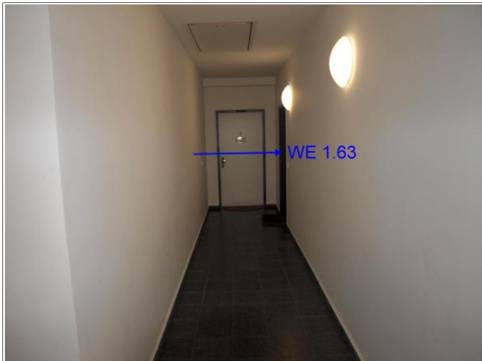
Abbildung 15: Ansicht des Wohnungszugangs von SE Nr. 1.63 im Dachgeschoss
