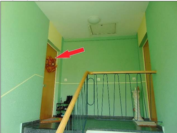
Foto 9 Treppenhaus Gorgasring 51 mit Pfeilmarkierung der Wohnungszugangstür von ETW-Nr. 63 im 3.OG.
