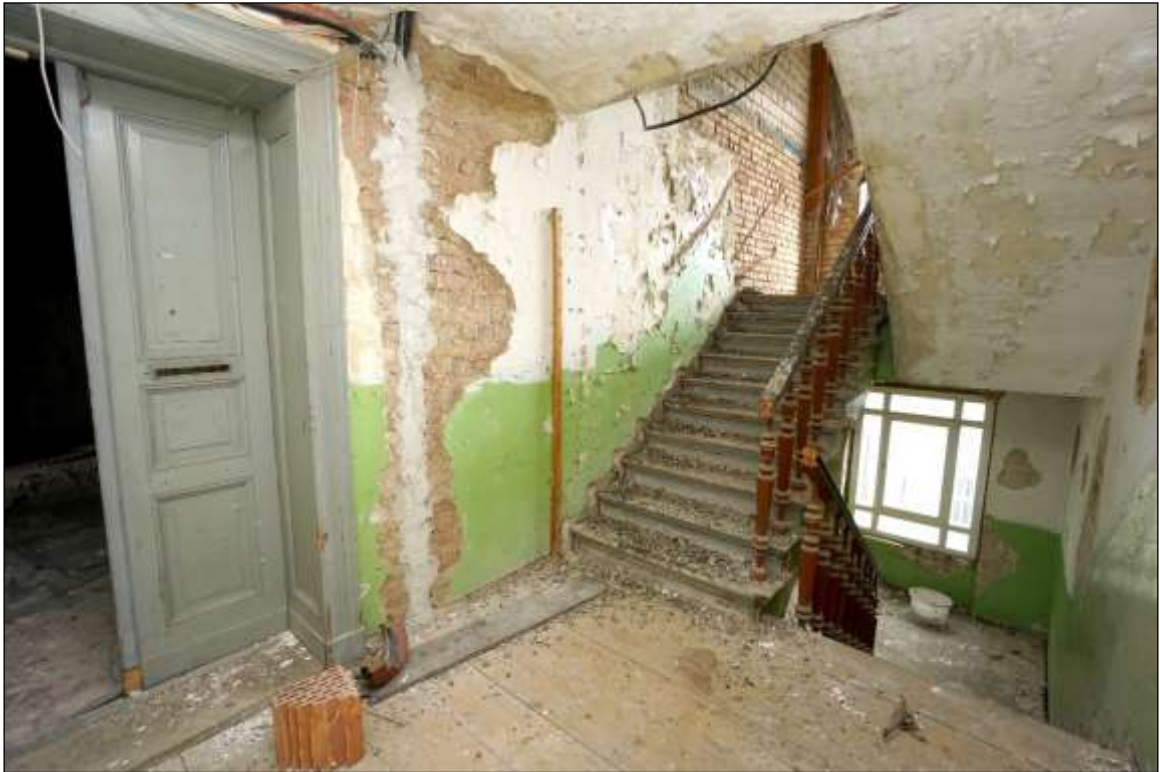
Treppenraum im Vorderhaus (Archivaufnahme von 2016)
