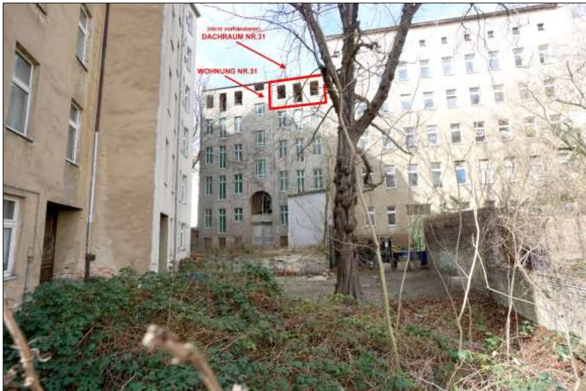
Ansicht des Gartenhauses, vom Grundstück Birkenstraße 13a aus betrachtet
