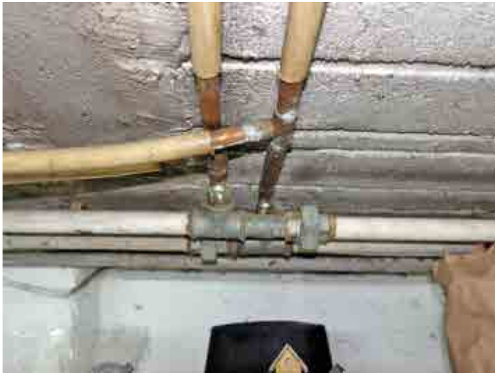
Keller, Detail Leitungsführung
