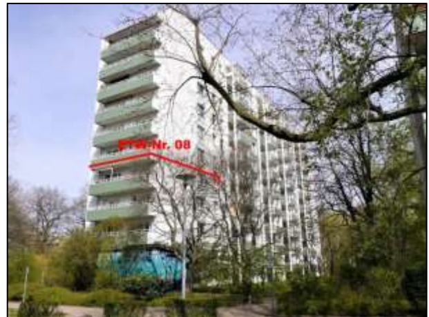
süd-westl. Giebelseite mit ETW-Nr. 8 im 3.OG
