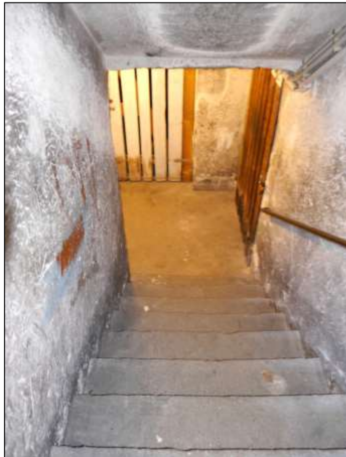
eingehauster Kellertreppenabgang im Gebäudeteil Holländerstr. 15 mit anbindendem Kellerflur und Holzlattenverschlagen
