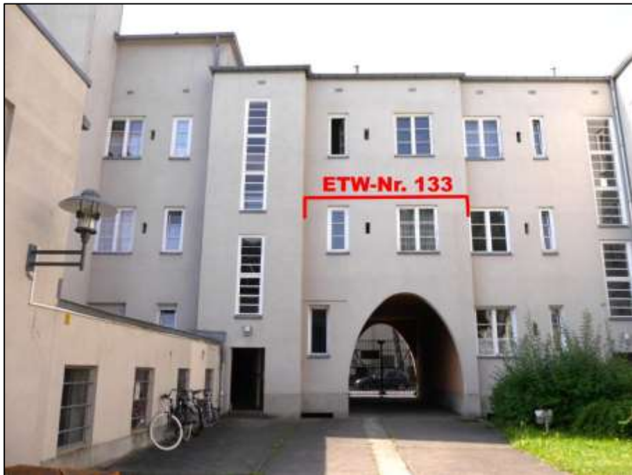
Blick aus dem Hofbereich des Blockinnenbereichs des hier betroffenen Grundstücks auf die rückwärtige nach Norden orientierte Front u.a. des Gebäudeteils Holländerstraße 15 mit Lage der ETW-Nr. 133 im 1.OG u.a. oberhalb der Gebäudedurchfahrt
