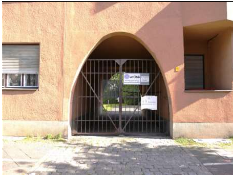
Blick aus dem Straßenraum vor dem Gebäudeteil Holländerstraße 15 auf die Gebäudedurchfahrt in den Blockinnenbereich
