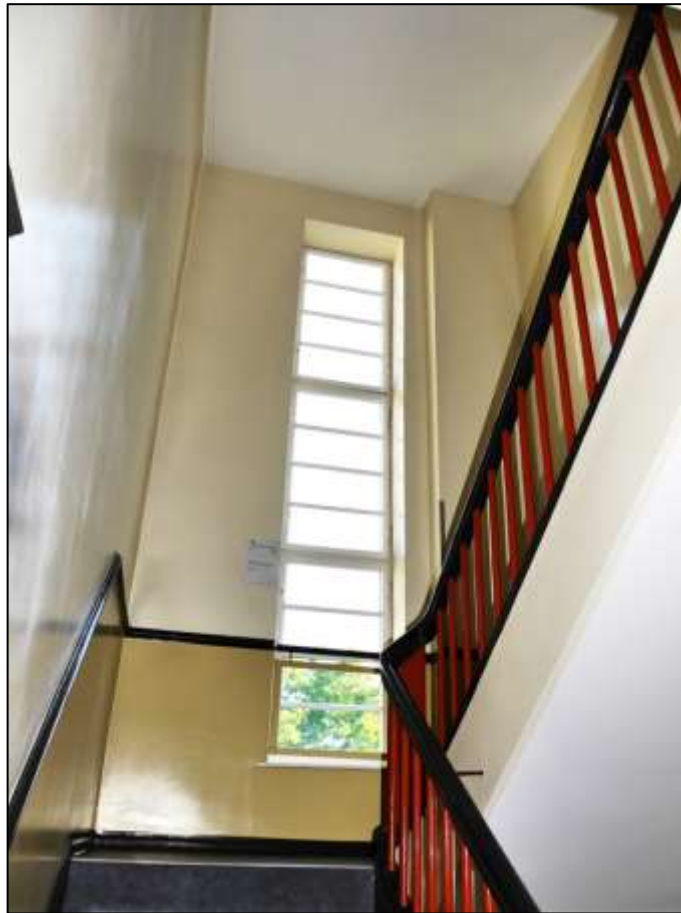
Treppenhaus- aufgang im Ge- bäudeteil Hol- länderstraße 15
