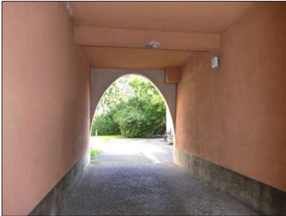
Blick durch die Gebäudedurchfahrt im Gebäudeteil Holländerstraße 15 in den Blockinnenbereich
