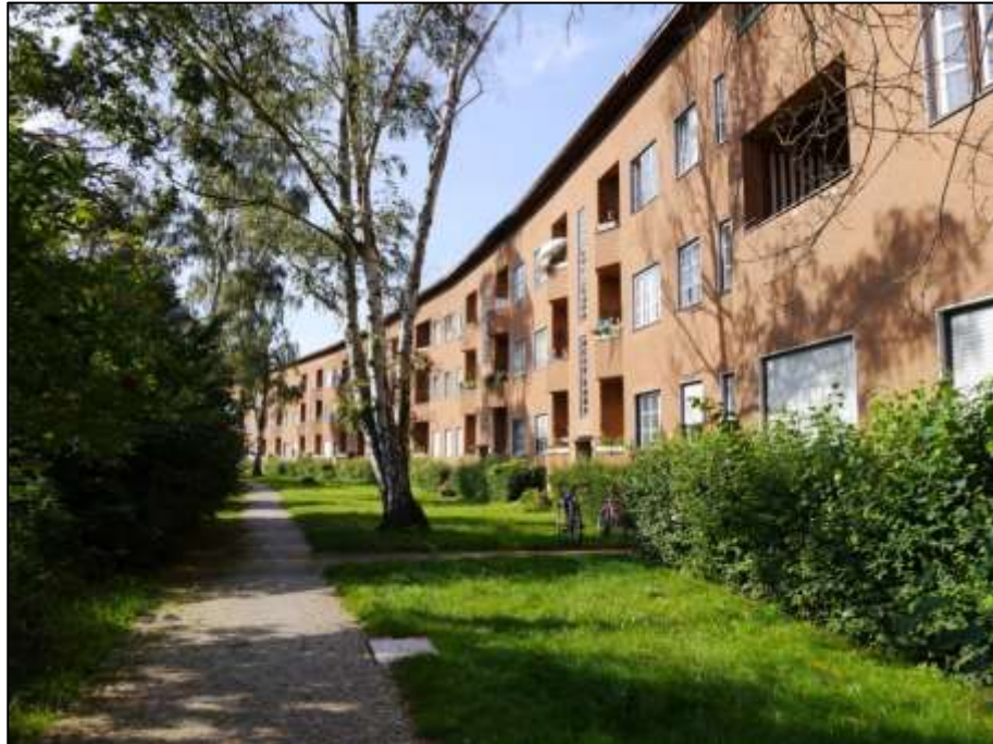
Abzweig der Erschließungsanlage „Am Schäfersee“ als reine Fuß-durchwegung vor der östlichen Front des hier betroffenen Grundstücks mit aufstehendem Wohnhausblock zwischen der Fuß- und Fahrrad-durchwegung entlang des Schäferseeparks und der Holländerstraße mit Blick nach Süden
