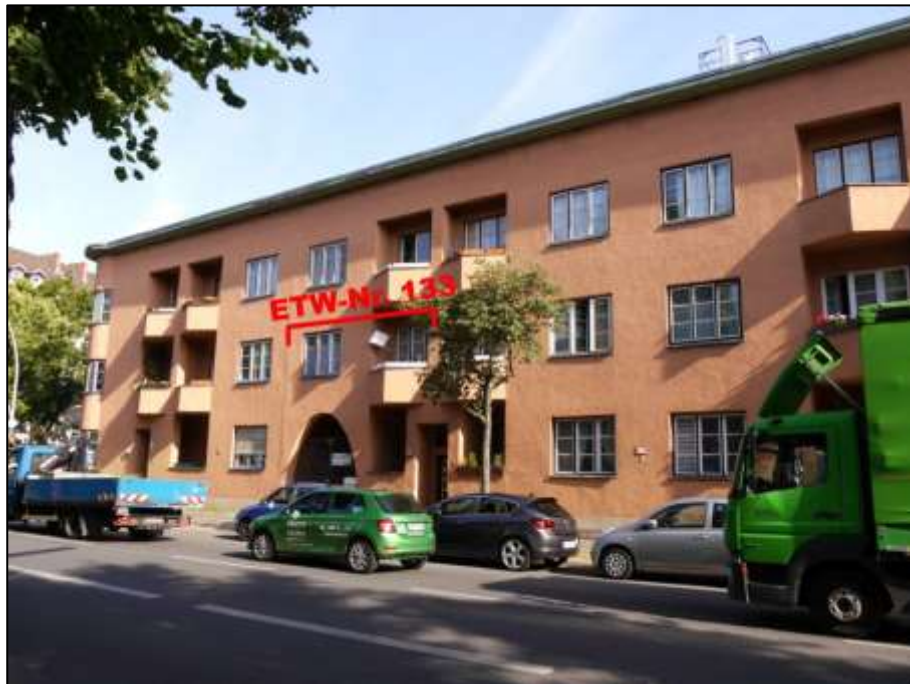
straßenseitige Gebäudefront des zur Holländerstraße orientierten Gebäudezugs u.a. mit Gebäudeteil Holländerstr. 15 und Lage der ETW-Nr. 133 im 1.OG
