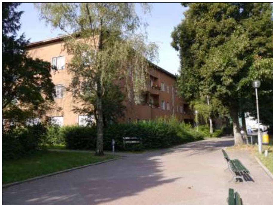
Blick nach Süd-Westen in die Erschließungsanlage „Am Schäfersee“ als Fuß- und Fahrraddurchwegung mit Lage des hier betroffenen Grundstücks auf der südlichen bzw. im Bild linken Seite der Durchwegung mit Abzweig als reine Fußdurchwegung links im Bild
