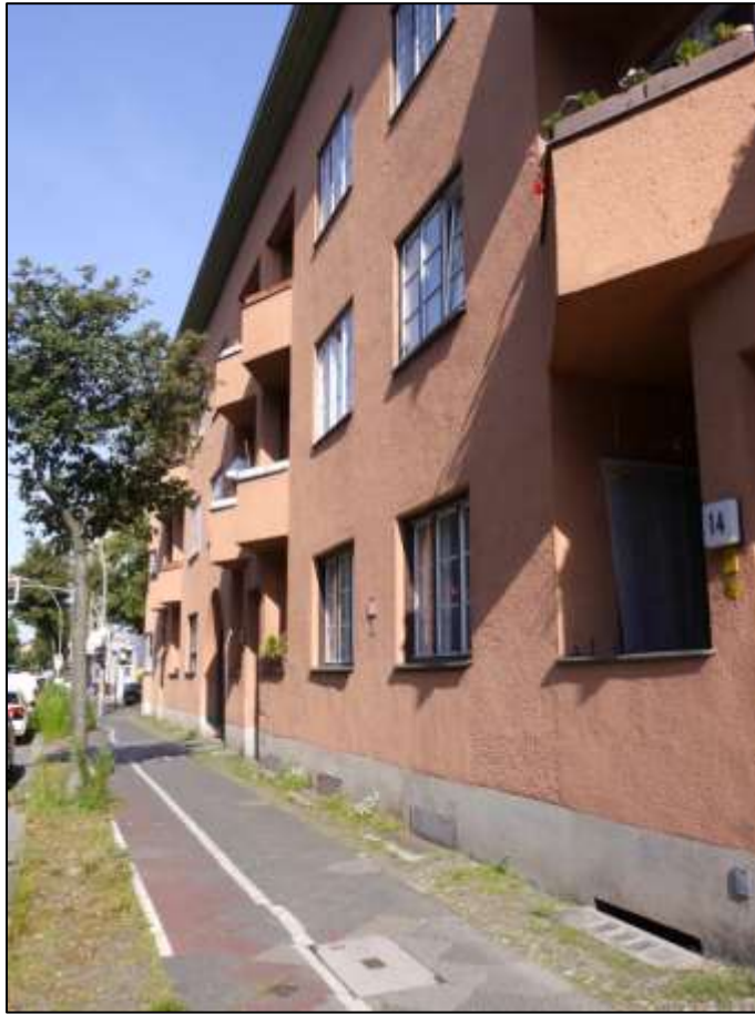
straßenseitige Front des zur Holländerstraße orientierten Ge- bäudezugs
