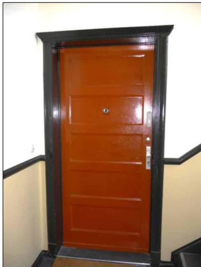
Wohnungsein- gangstür des Wohnungsei- gentums Nr. 133 im 1. Ober- geschoss pos- talisches rechts im Gebäudeteil Holländerstraße 15
