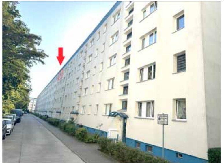
5-geschossiges, unterkellertes Mehrfamilienhaus (Kennzeichnung der Lage des zu bewertenden Sondereigentums)
