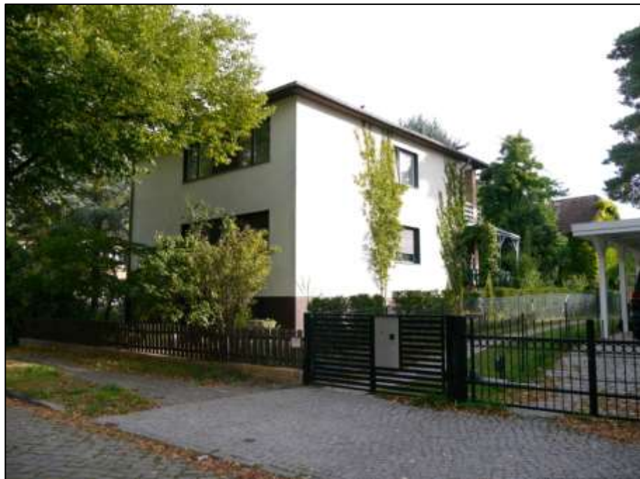
straßenseitige Front des auf dem Grundstück Petkusser Str. 3A aufstehenden Zweifamilienhauses und zum rechten Bauwich nach Süd-Osten orientierte Front des Gebäudes
