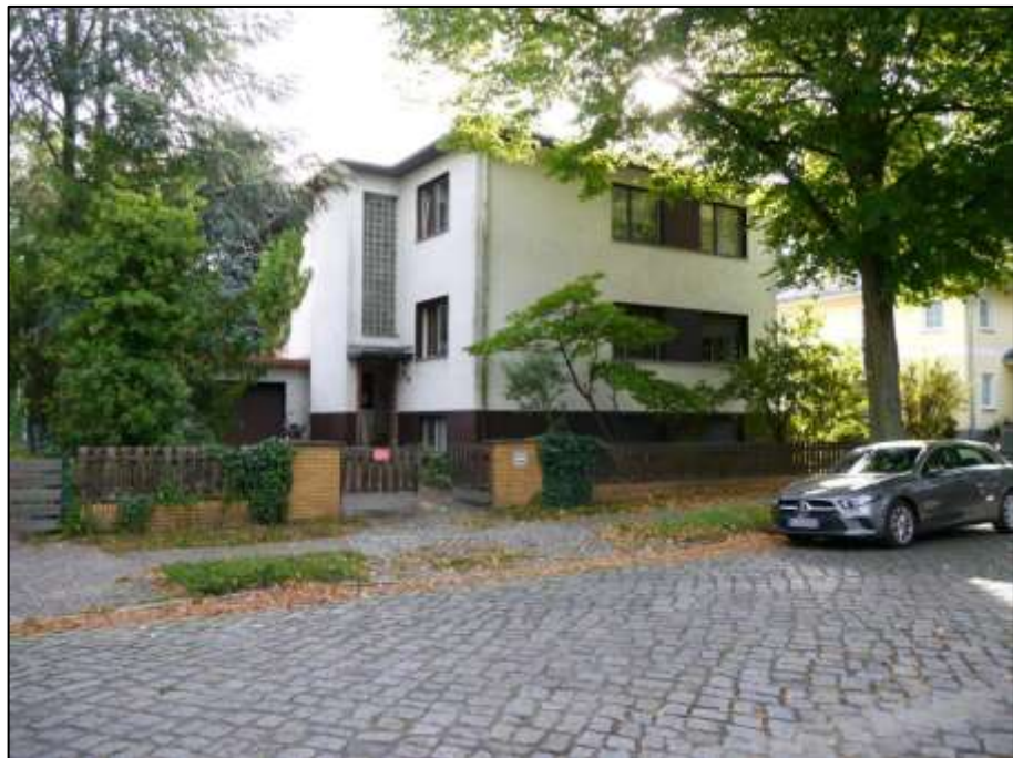
straßenseitige Front des Grundstücks Petkusser Str. 3A mit aufstehendem Zweifamilienhaus und Hauseingangsfront in der zum linken Bauwich orientierten Gebäudeseite mit neutralem Treppenhaus und anbindendem Garagen-Anbau
