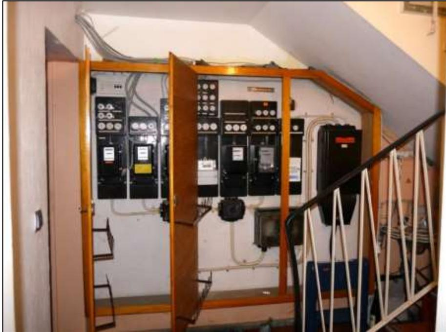
Zählerschrank mit Sicherungstableaus der Hochparterrewohnung und der Kellerräume, des Treppenhauses und der Garage u.a. mit Stromzählern für die Nachstromspeicherheizungen im Gebäude
