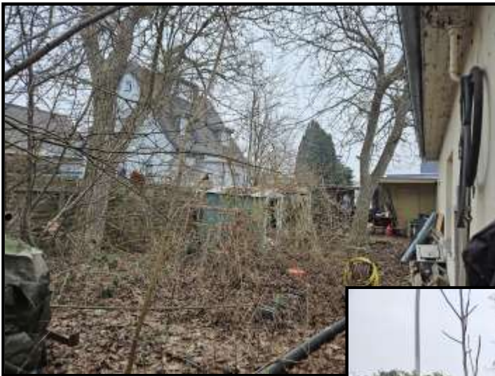
Bild 11: Ansicht von Westen
