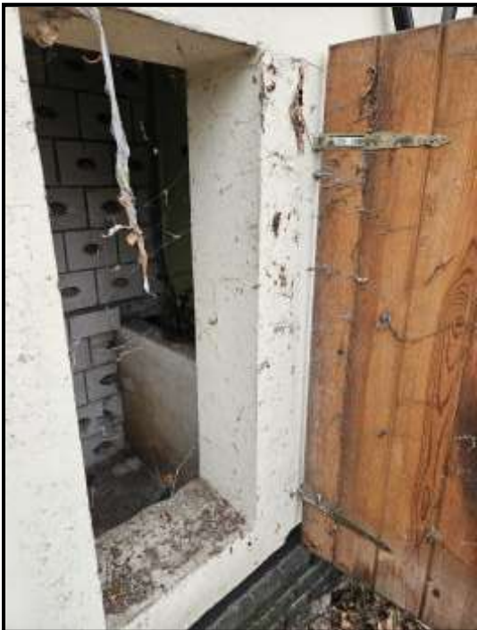
Bild 9: Zugang Öltank von außen
