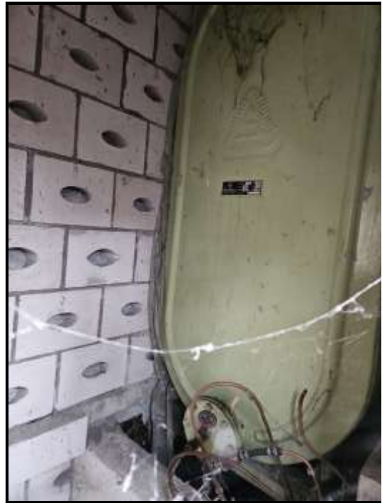
Bild 10: Öltank 1500 Liter
