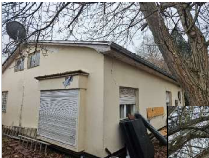
Bild 3: Ansicht von Nordosten
