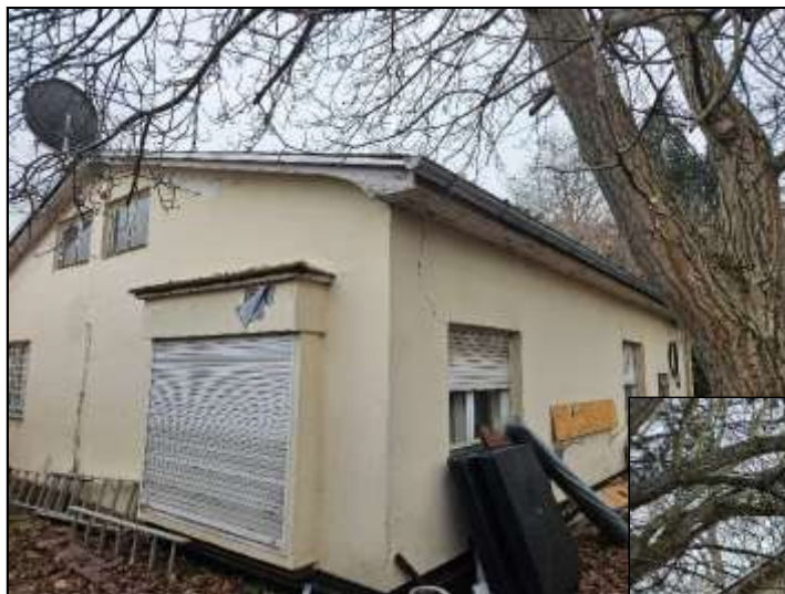
Bild 3: Ansicht von Nordosten
