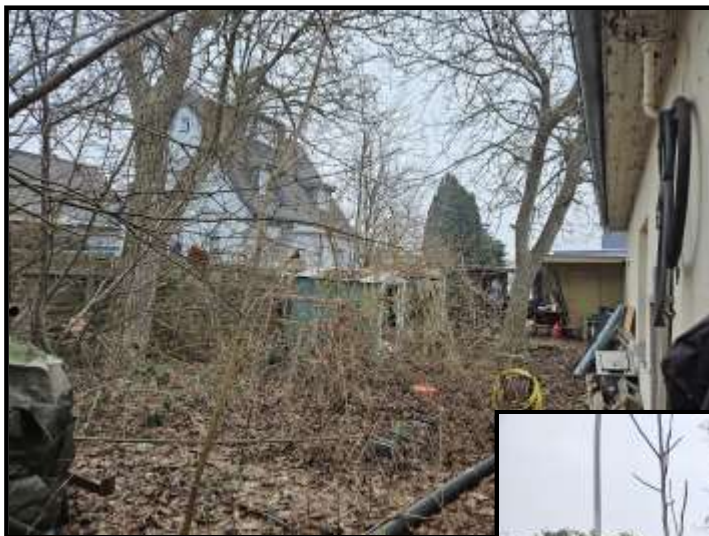
Bild 11: Ansicht von Westen
