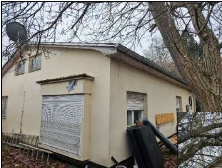
Bild 3: Ansicht von Nordosten
