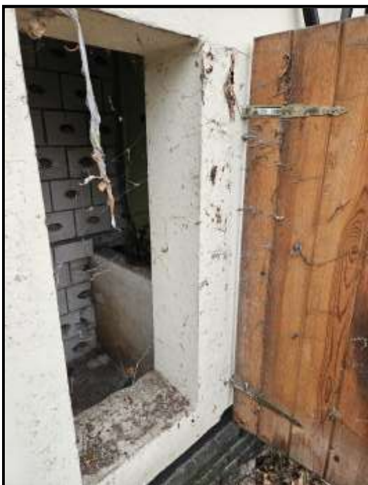
Bild 9: Zugang Öltank von außen
