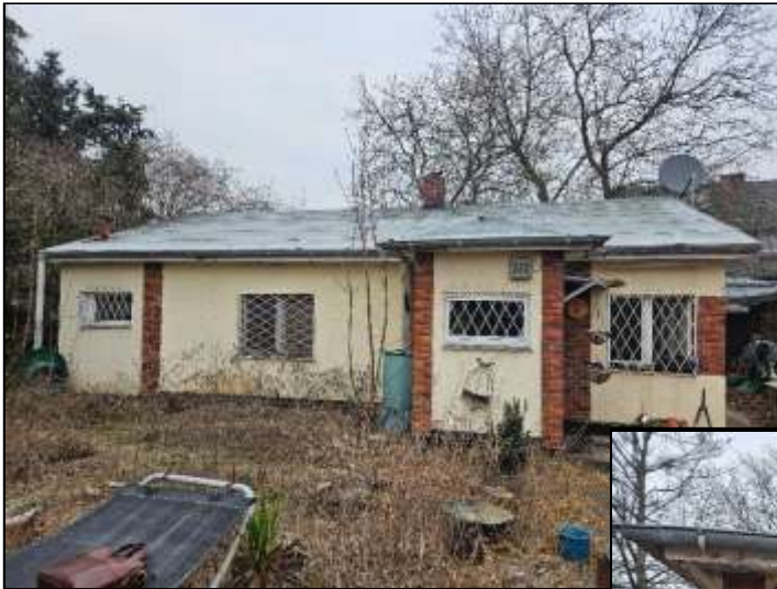
Bild 1: Brunsbütteler Damm 220 Ansicht von Süden (Straßenseite)
