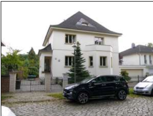
straßenseitige Gebäudefront mit Hauseingang
