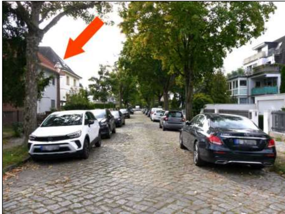
Blick in die Seydlitzstraße nach Süd-Osten mit Lage des auf dem Grundstück Seydlitzstr. 29 aufstehenden Einfamilienhauses auf der nord-östlichen bzw. im Bild linken Straßenseite (Pfeil)
