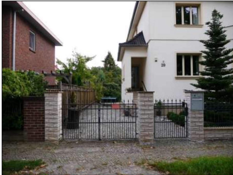
straßenseitige Einfriedung des Grundstücks Seydlitzstr. 29 im Bereich der Zuwegung und eines ungedeckten PKW-Stellplatzes im linken Bauwich des auf dem Grundstück aufstehenden Einfamilienhauses mit Doppelflügel-Toranlage der Zufahrt zum PPKW-Stellplatz und separater Schlußpforte zur Hauszuwegung
