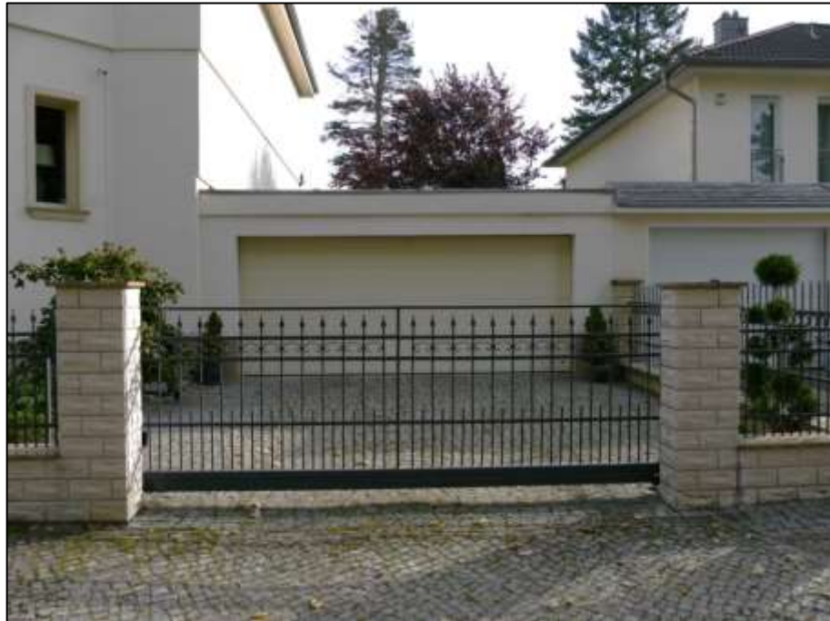
straßenseitige Einfriedung des Grundstücks Seydlitzstr. 29 im Bereich der Garagenzufahrt mit freitragendem elektrisch betriebenen Schiebtor zu dem im Hintergrund belegenen Garagen-Anbau an das Wohngebäude als Doppelgarage bzw. Grenzbebauung zu dem rechten Nachbargrundstück
