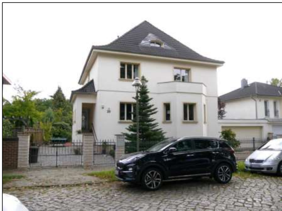
straßenseitige Front des auf dem Grundstück Seydlitzstr. 29 aufstehenden Einfamilienhauses und zum linken Bauwich orientierter Haus- eingangsfrent nebst Windfangvorbau
