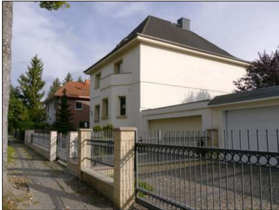
straßenseitige Front des auf dem Grundstück Seydlitzstr. 29 aufstehenden Einfamilienhauses mit Garagen-Anbau als Doppelgarage im rechten Bauwich
