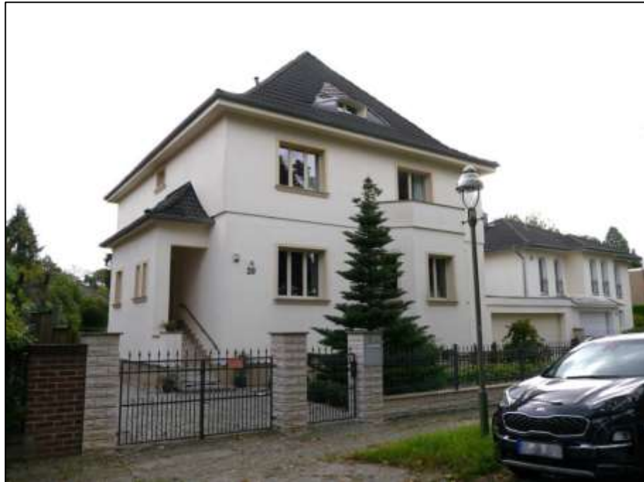
straßenseitige Front des auf dem Grundstück Seydlitzstr. 29 aufstehenden Einfamilienhauses und zum linken Bauwich orientierter Haus- eingangsfrent nebst Windfangvorbau
